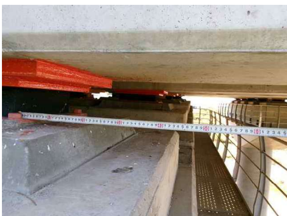
받침장치 연단거리 측정
