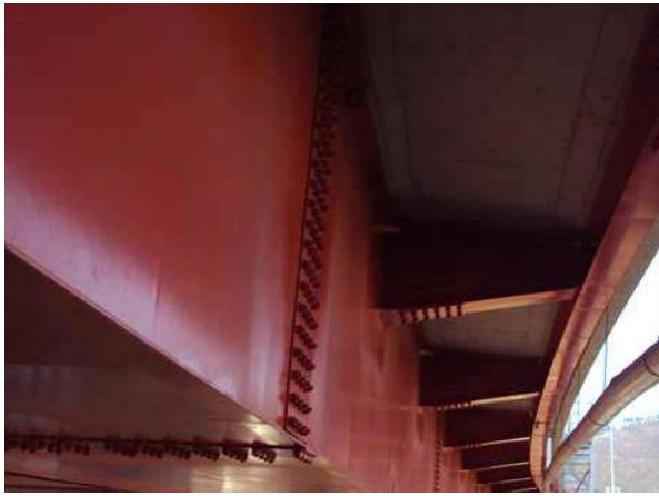
바닥판 하면 상태양호
