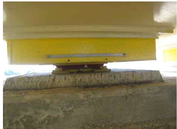
교량 받침 가동량 측정
