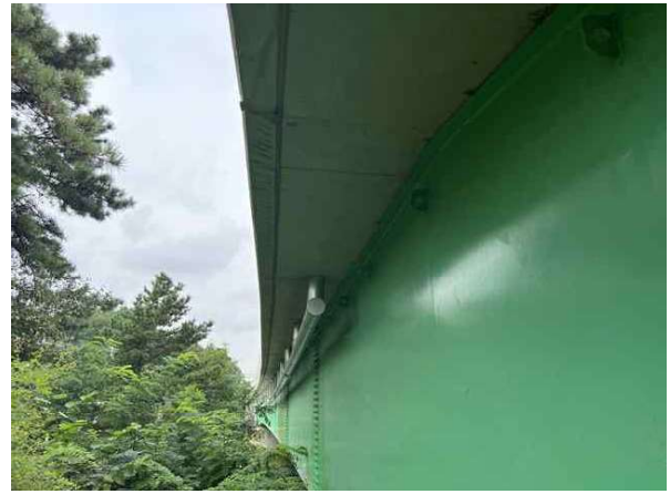
바닥판 하면 S2 상태양호
