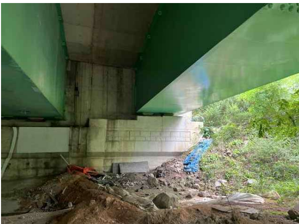
교대 A2 상태양호
