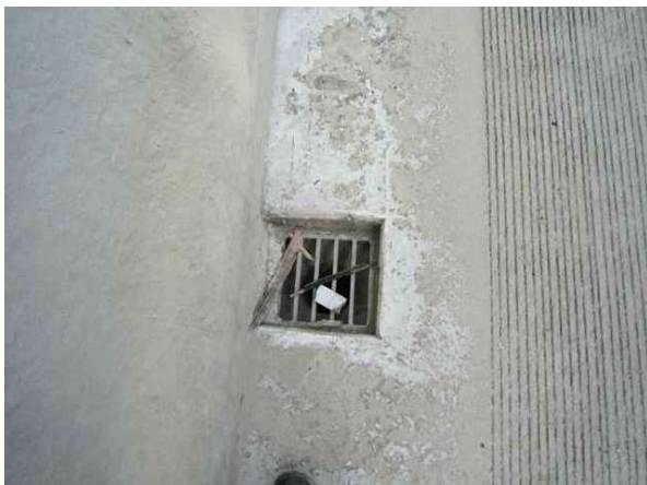
배수구 상태 양호
