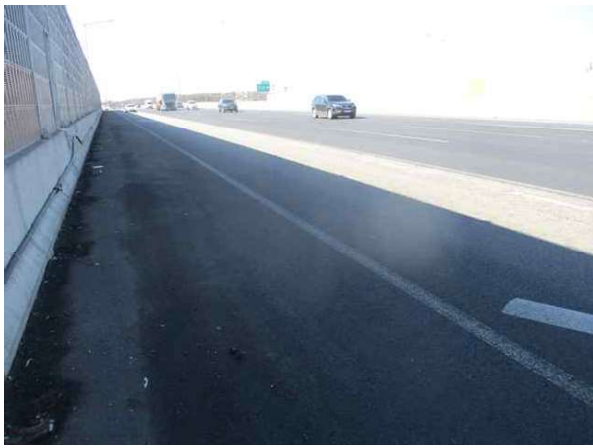
교면포장 S3 상태양호
