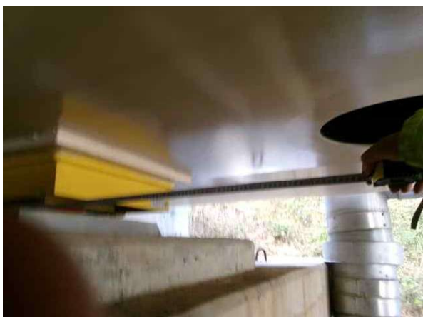
받침장치 연단거리 측정
