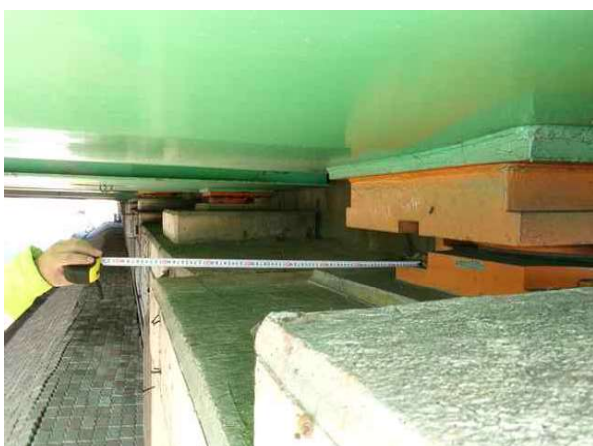
받침장치 연단거리 측정
