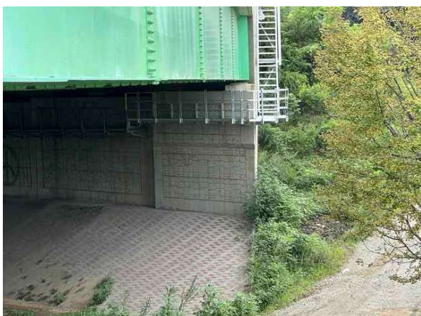
교대 A2 상태양호
