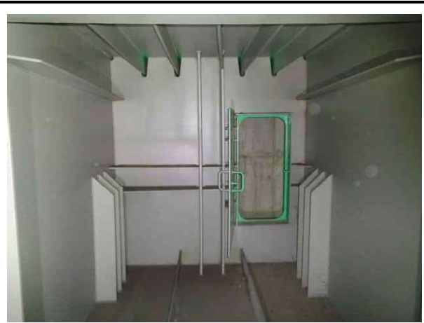
거더내부 S2 상태양호
