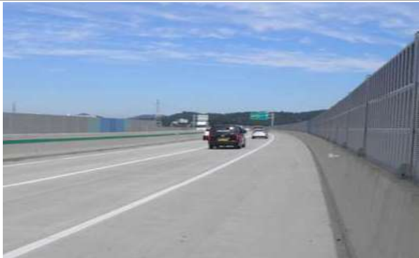
방호벽, 방음벽 전경
