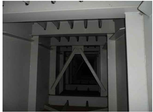
거더내부 S4 상태양호
