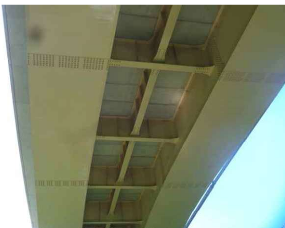
가로보 및 세로보 상태양호(STB)
