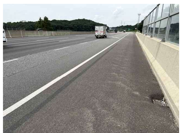
교면포장 S2 상태양호
