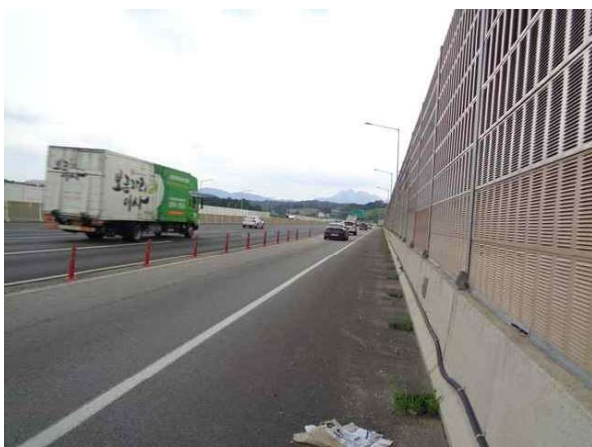
교면포장 S1 상태양호
