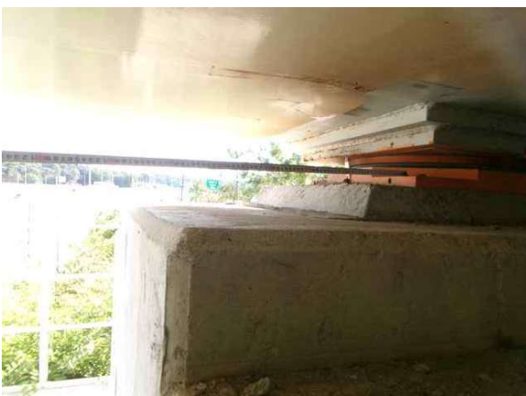
받침장치 연단거리 측정
