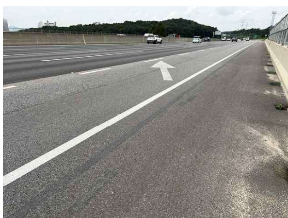
교면포장 S1 상태양호
