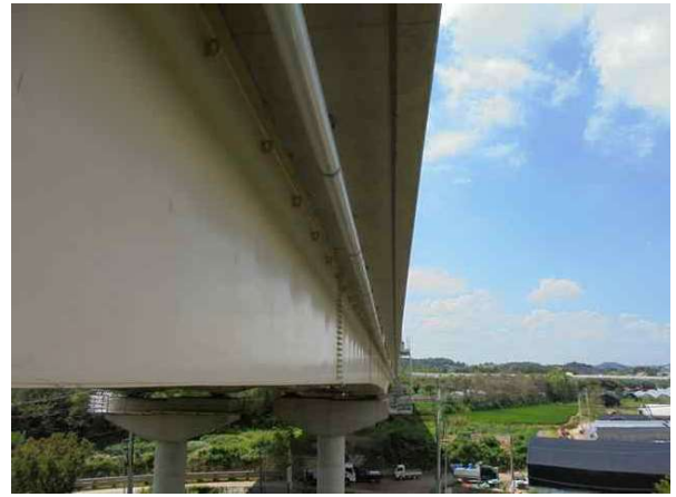
배수관 상태 양호
