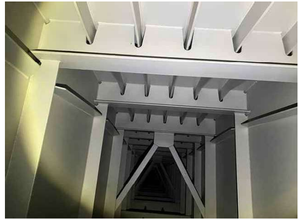
거더내부 S2 상태양호
