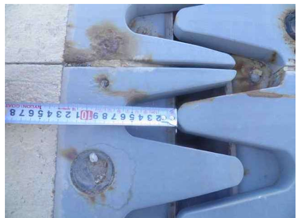
신축이음 이동량 측정
