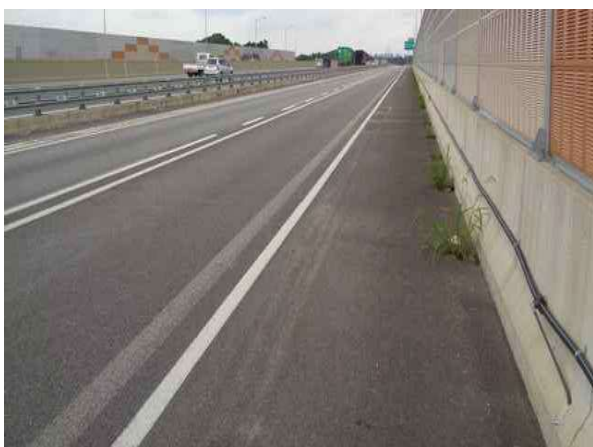
교면포장 S3 상태양호
