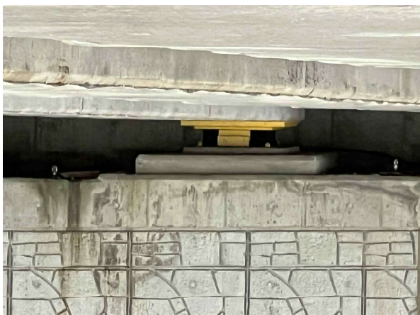
교량받침 A1-SH2 상태양호-문산방향
