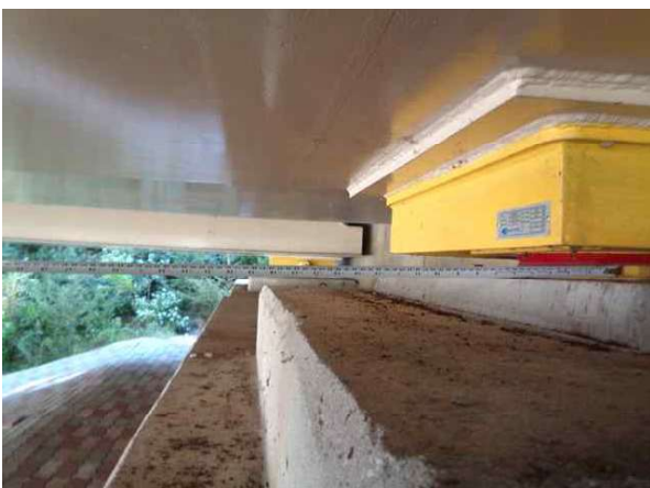
받침장치 연단거리 측정
