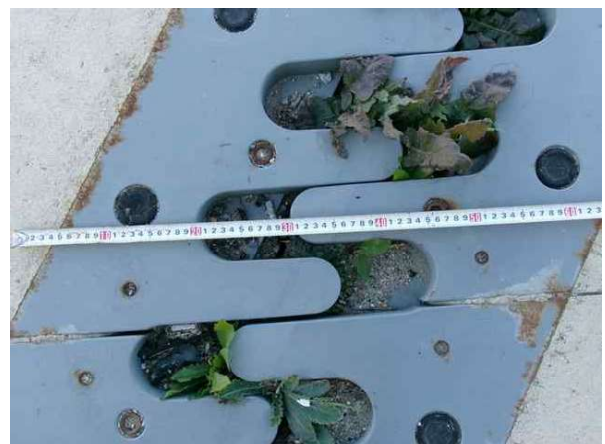
신축이음 이동량 측정
