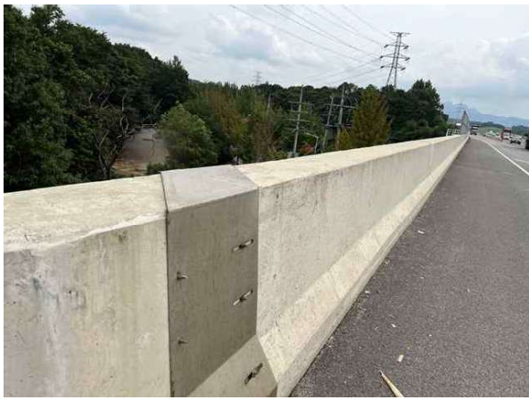
방호벽 S2 상태양호
