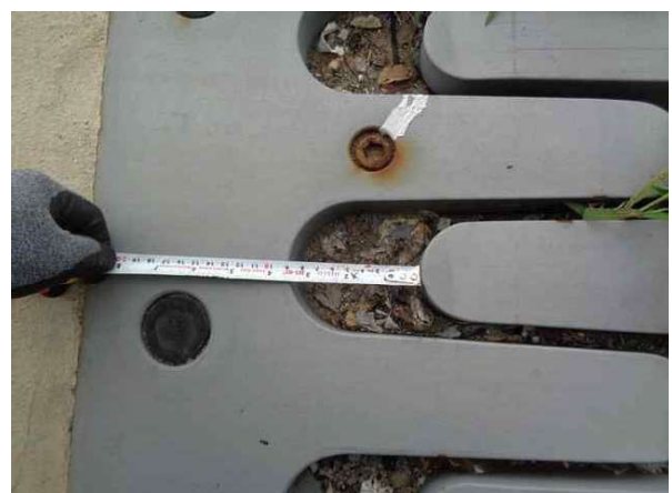
신축이음 이동량 측정
