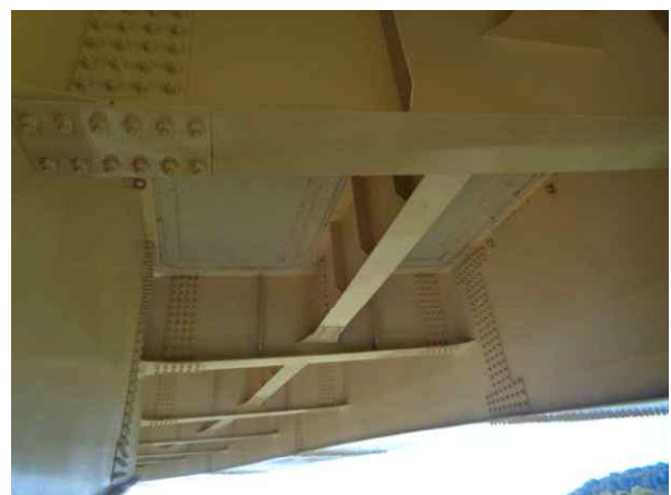
가로보 및 세로보 상태양호(STB)
