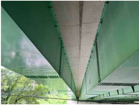
바닥판 하면 S2 상태양호
