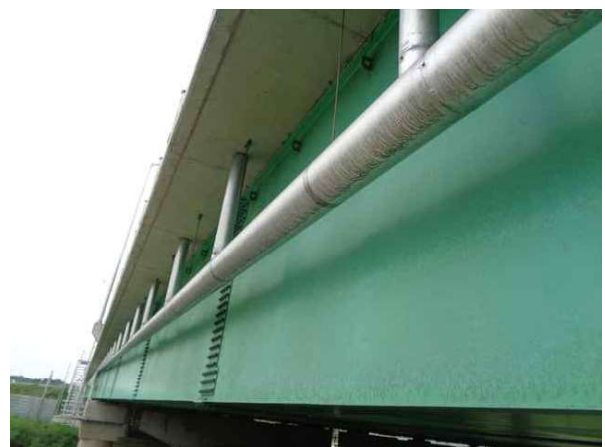
배수시설 S4 배수관 상태양호
