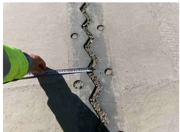
신축이음 이동량 측정
