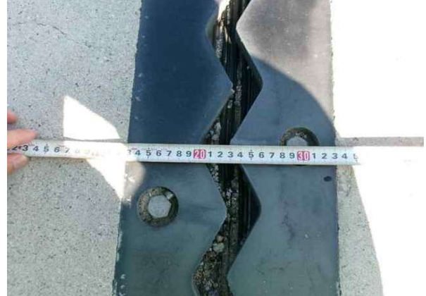
신축이음 이동량 측정
