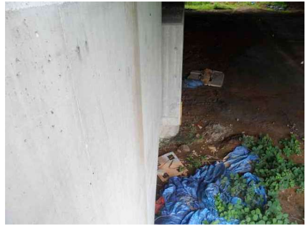
교각 P1 코핑부 상태양호
