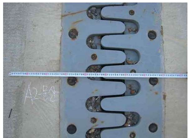
신축이음 이동량 측정
