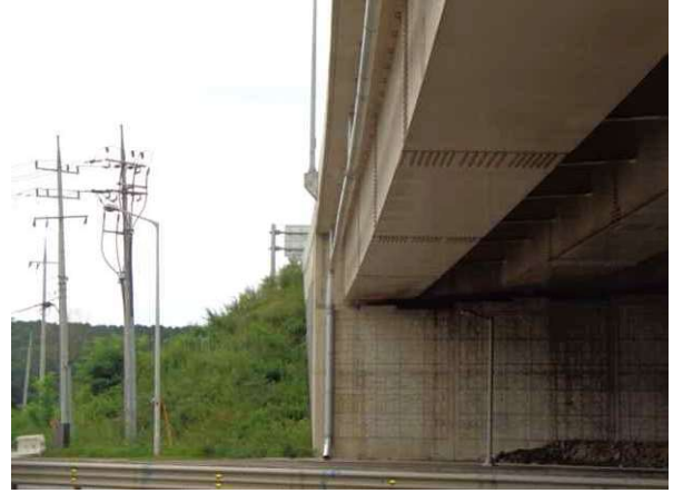
배수관 상태 양호
