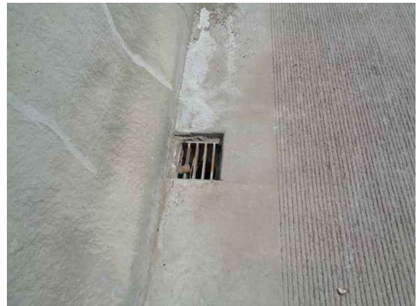
배수구 상태 양호
