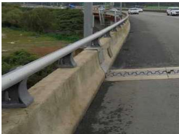
난간 및 연석 상태양호
