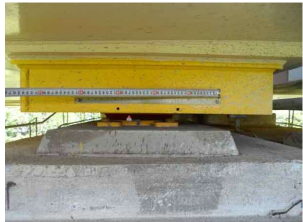
교량 받침 가동량 측정
