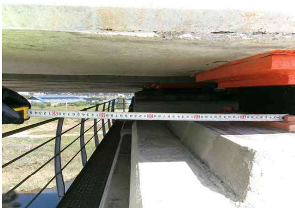
받침장치 연단거리 측정
