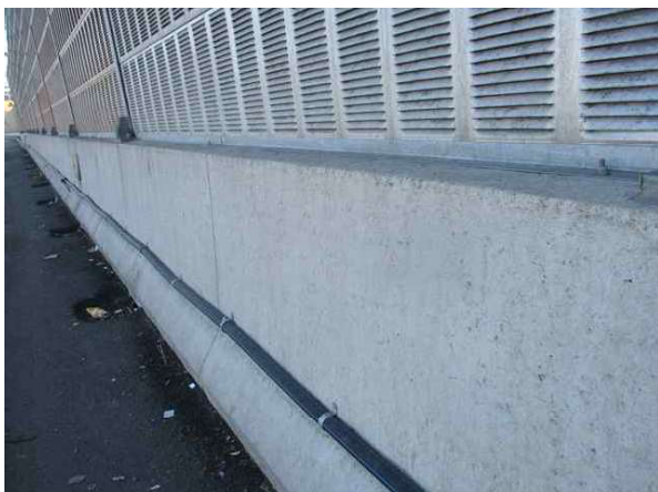
방호벽 S2 상태양호
