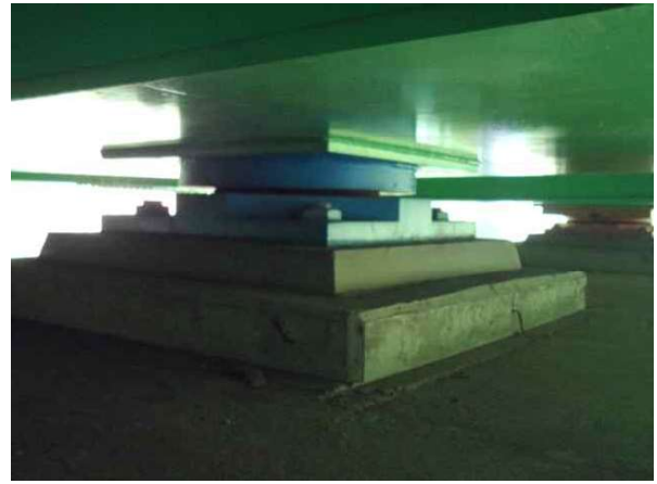
교량받침 P1-Sh2 상태양호
