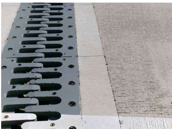
P4 후타재 균열( C_w=0.3\text{mm} 미만)
