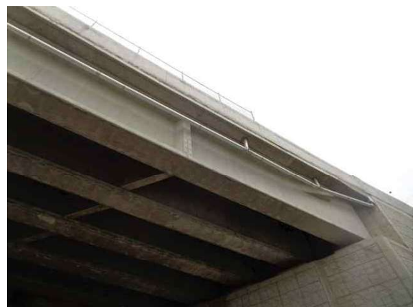
배수관 상태 양호-문산방향
