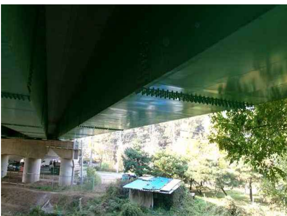
거터외부 S1 상태양호
