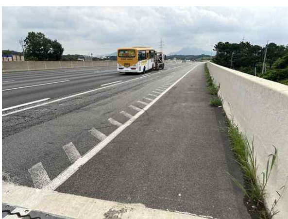
교면포장 S1 상태양호
