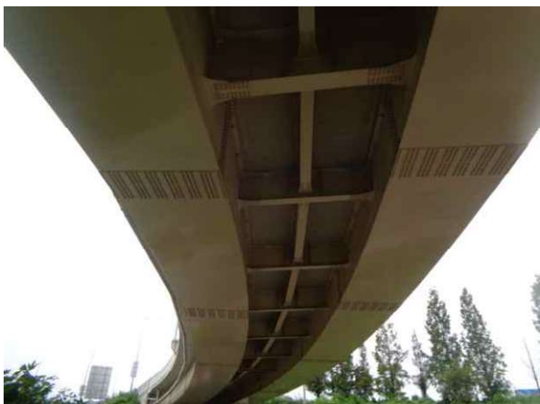
거더외부, 바닥판하면 전경
