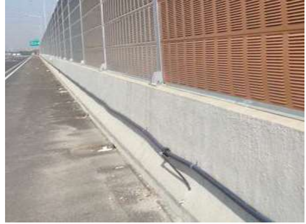
방호벽 S2 상태양호
