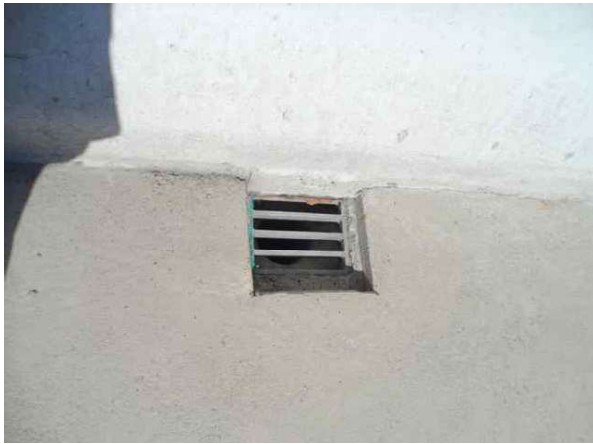
배수시설 배수구 상태양호
