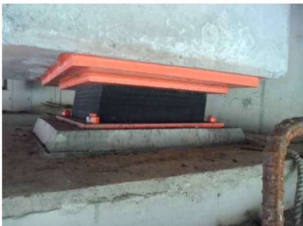
교량받침 A2-SH5 상태양호-서울방향
