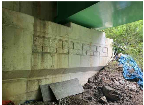
교대 A2 상태양호
