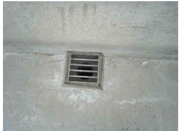
배수구 상태 양호
