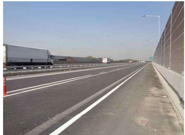
교면포장 S2 상태양호
