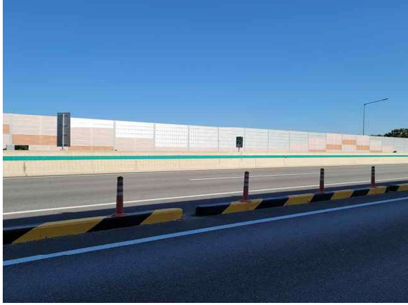
S2 균열 (0.2mm/1.5m×10EA)
