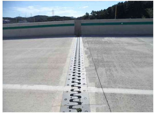
신축이음 A2 상태양호
