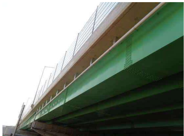
배수시설 S4 배수관 상태양호
