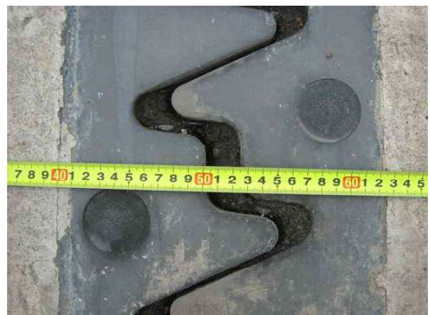
신축이음 이동량 측정
