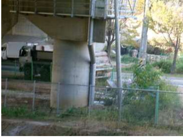
교각 P1 기둥부 상태양호
