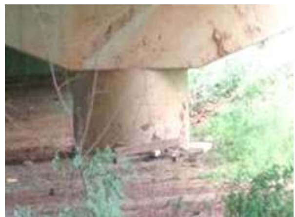
교각 P1 기둥부 상태양호
