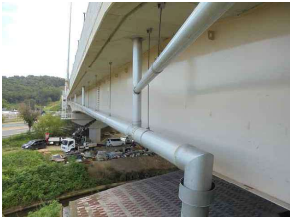
배수관 상태 양호
