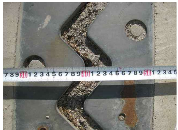
신축이음 이동량 측정
