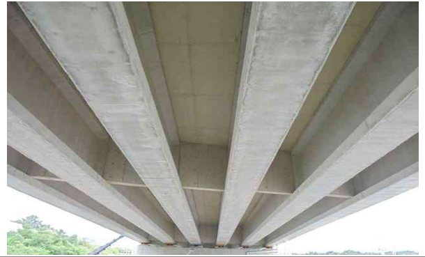
거더, 바닥판하면 전경
