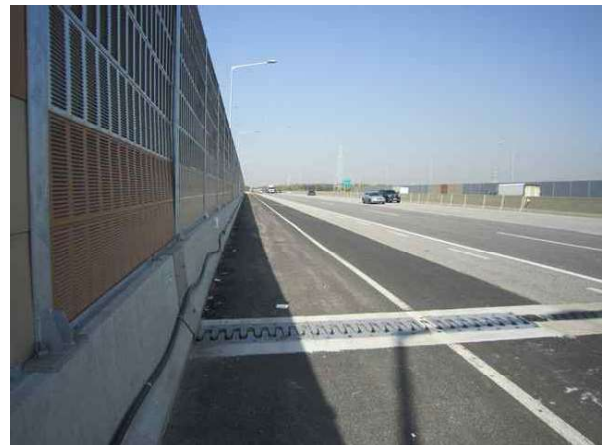
교면포장 S4 상태양호
