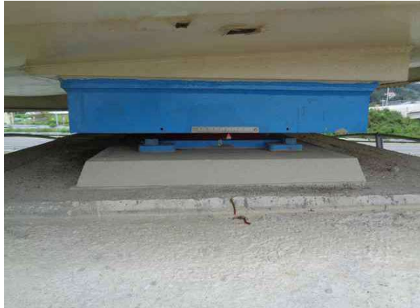
교량받침 P1-Sh2 상태양호
