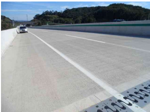
교면포장 S3 상태양호
