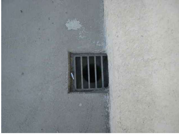
배수구 상태 양호 - 금회
