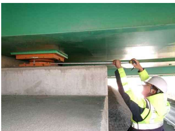
받침장치 연단거리 측정
