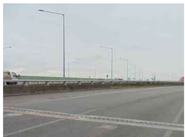
난간 및 연석 상태양호
