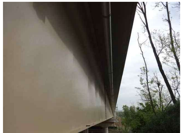
배수관 상태 양호
