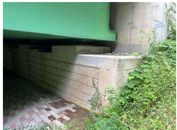
교대 A2 상태양호
