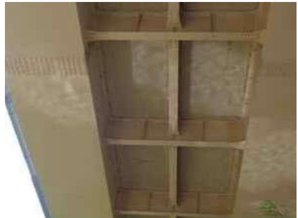
가로보 및 세로보 상태양호
