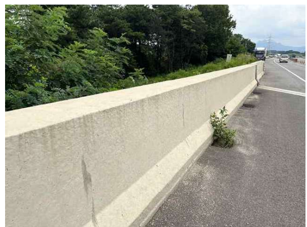
방호벽 S1 상태양호
