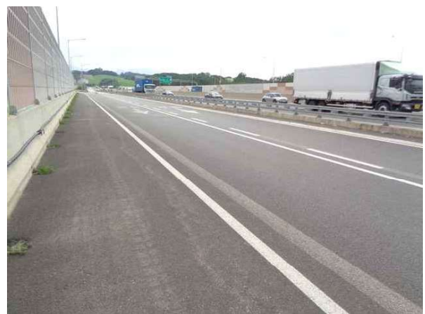
교면포장 S4 상태양호
