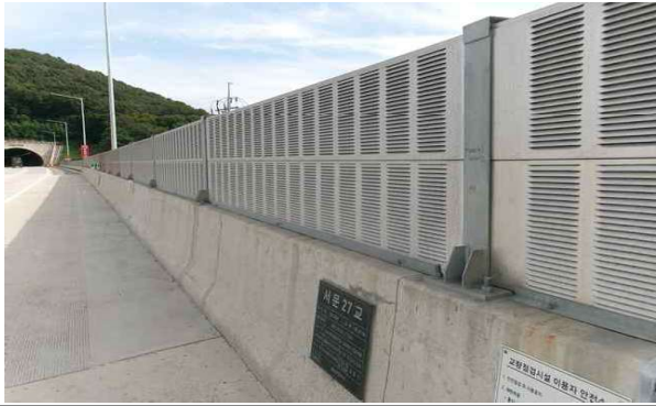
방호벽, 방음벽 전경
