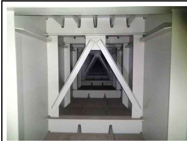
거더내부 S1 상태양호
