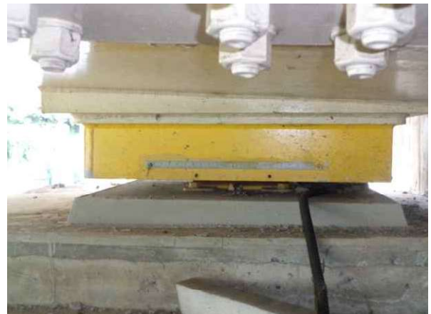
교량 받침 가동량 측정
