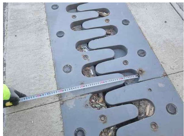
신축이음 이동량 측정
