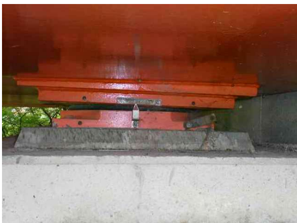
받침장치 가동량 측정
