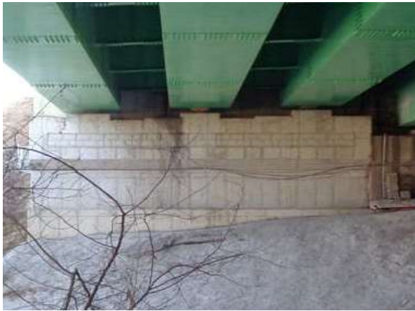
교대 A1 상태양호
