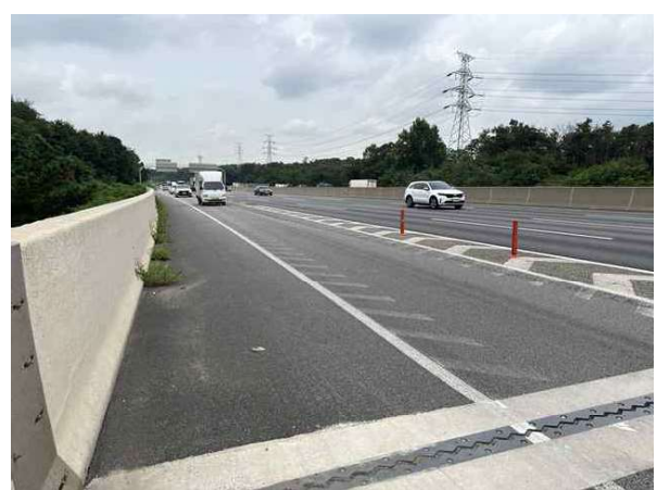
교면포장 S2 상태양호
