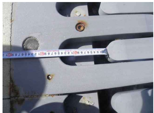
신축이음 이동량 측정
