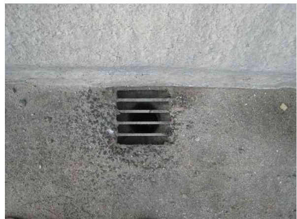
배수구 상태 양호
