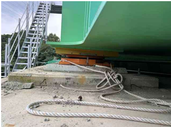
교량받침 P1-Sh2 상태양호
