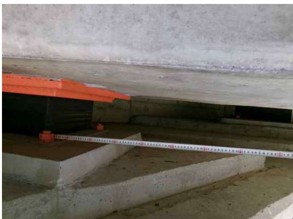
받침장치 연단거리 측정
