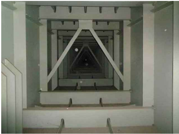
거더내부 S1 상태양호
