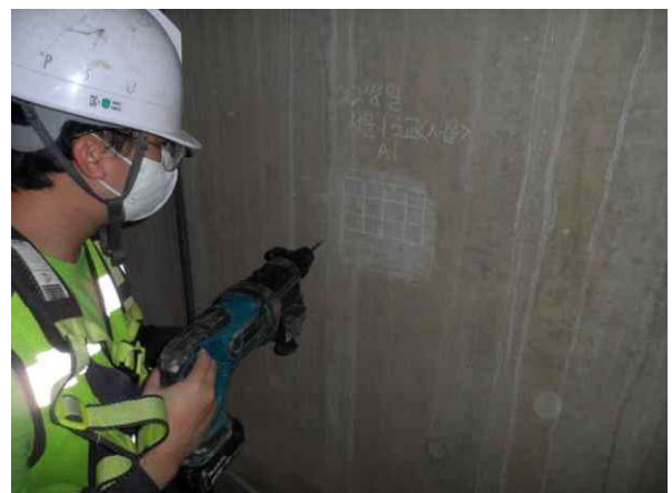
탄산화깊이 측정 현황
