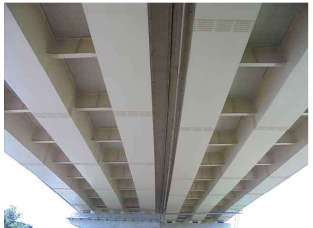
거더(S.T.B), 바닥판하면 전경
