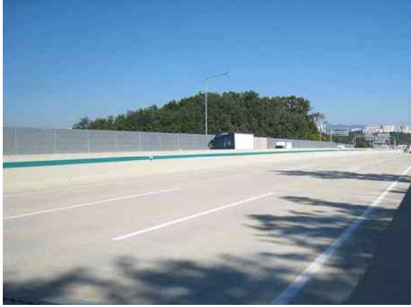
중분대 상태양호 - 금회
