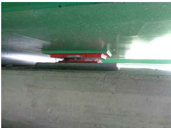
교량받침 A2-Sh1 상태양호
