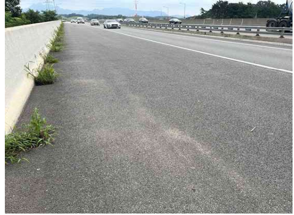
교면포장 S2 상태양호
