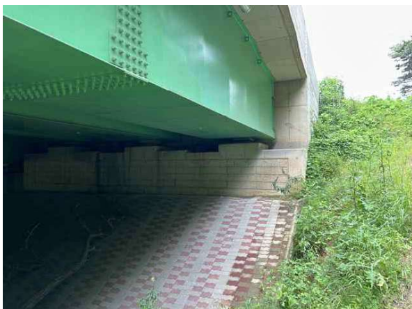
교대 A2 상태양호
