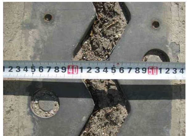
신축이음 이동량 측정
