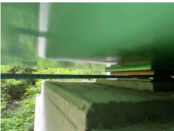
받침장치 연단거리 측정
