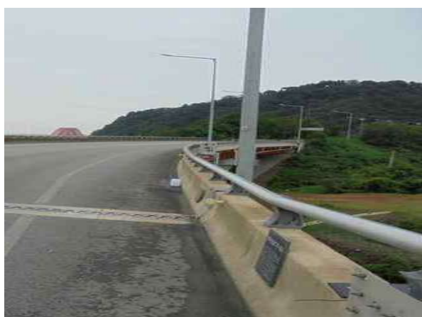
난간 및 연석 상태양호
