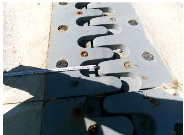
신축이음 이동량 측정
