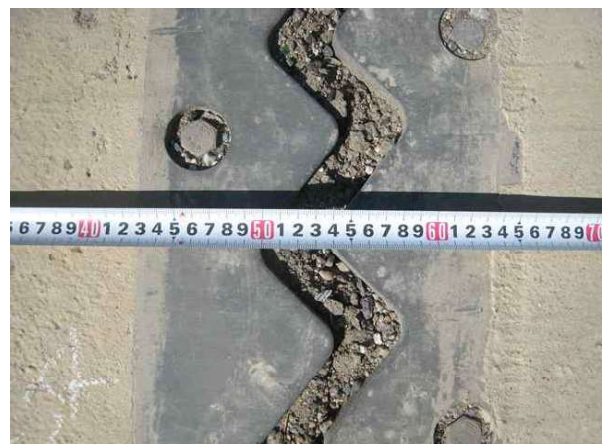
신축이음 이동량 측정
