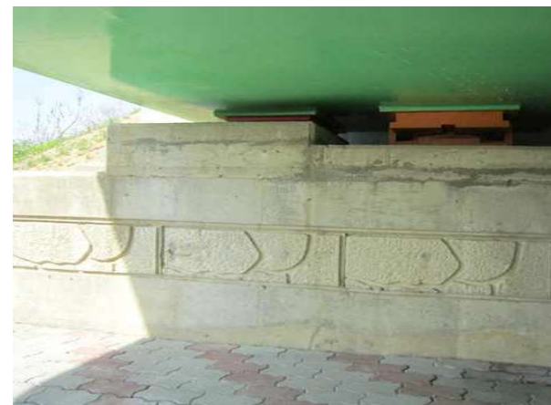
교대 A1 상태양호
