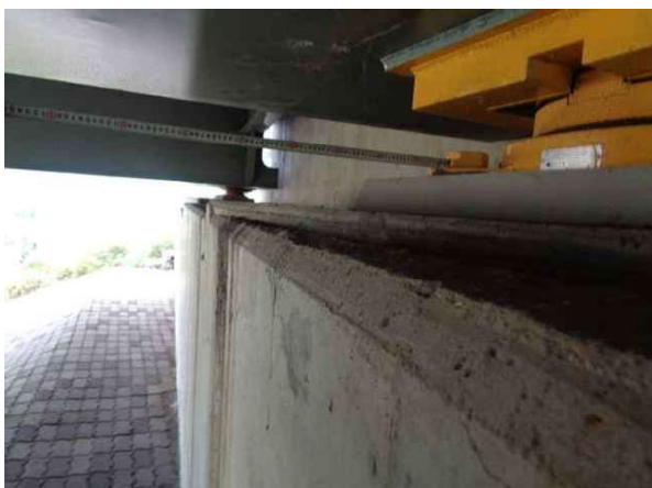
받침장치 연단거리 측정
