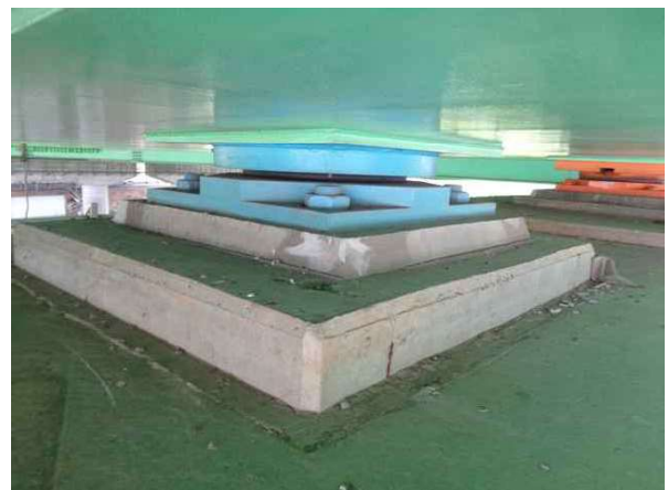
교량받침 P2-Sh3 상태양호
