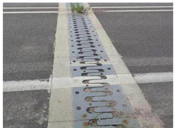
신축이음 A1 후타재 상태양호
