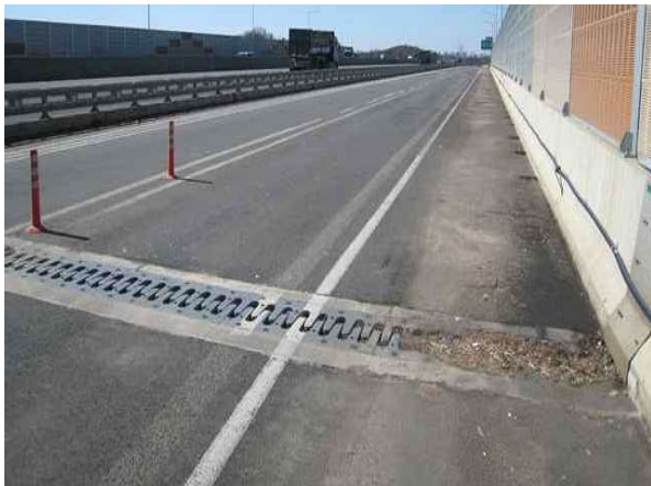
교면포장 S1 상태양호
