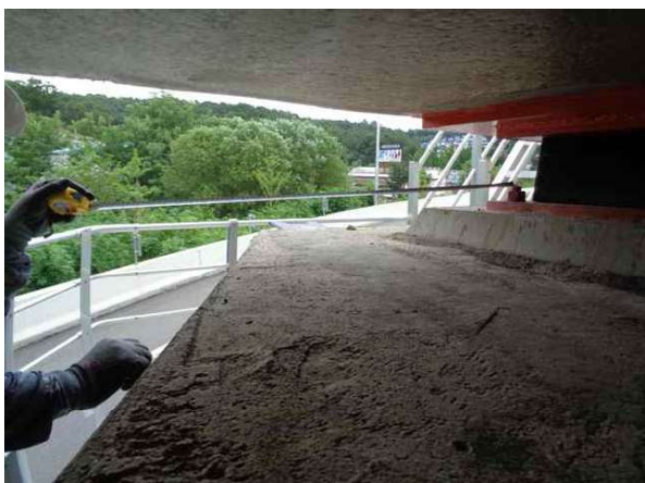
받침장치 연단거리 측정
