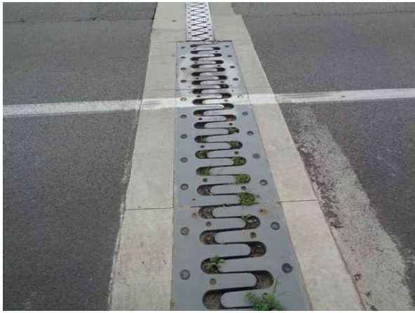
신축이음 A1 본체 상태양호
