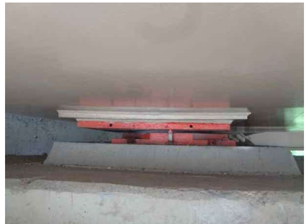
교량 받침 가동량 측정
