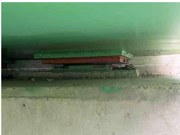
교량받침 A2-Sh2 상태양호
