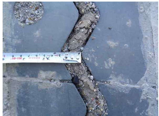
신축이음 이동량 측정
