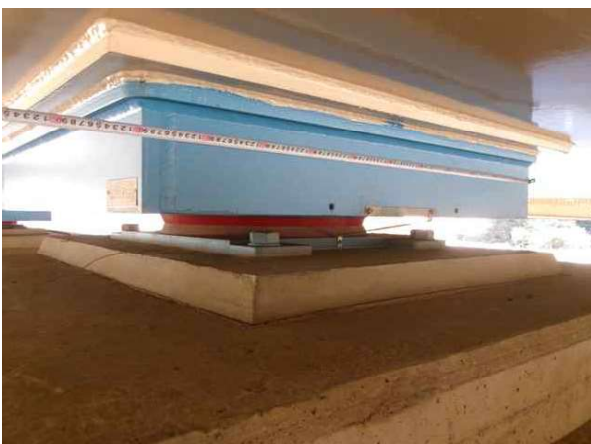
받침장치 연단거리 측정
