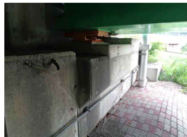
교대 A2 상태양호
