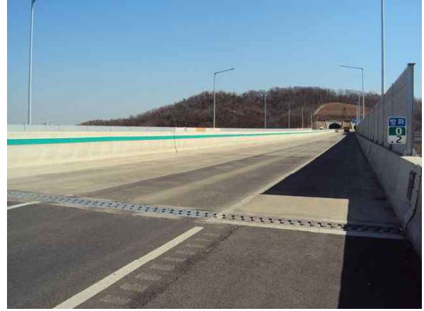
교면포장 상태양호 - 22년 상반기
