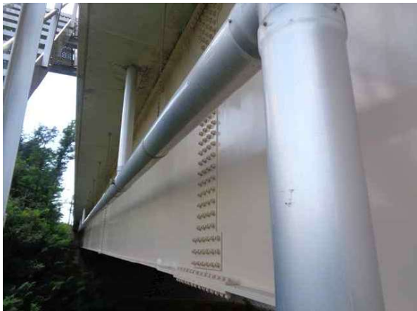
배수관 상태 양호 - 금회
