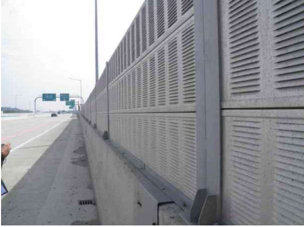
방음벽 상태 양호
