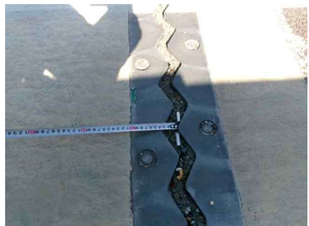
신축이음 이동량 측정
