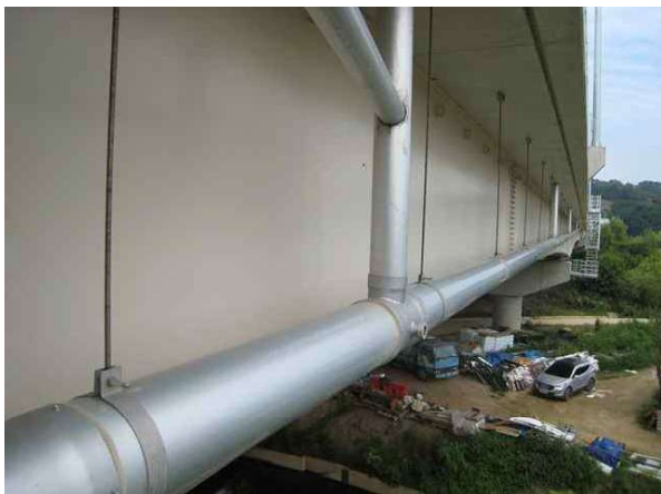
배수관 상태 양호
