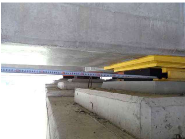
받침장치 연단거리 측정
