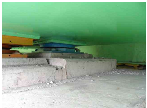
교량받침 P1-Sh1 상태양호
