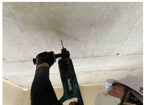
탄산화깊이 측정 현황
