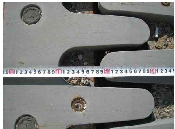
신축이음 이동량 측정
