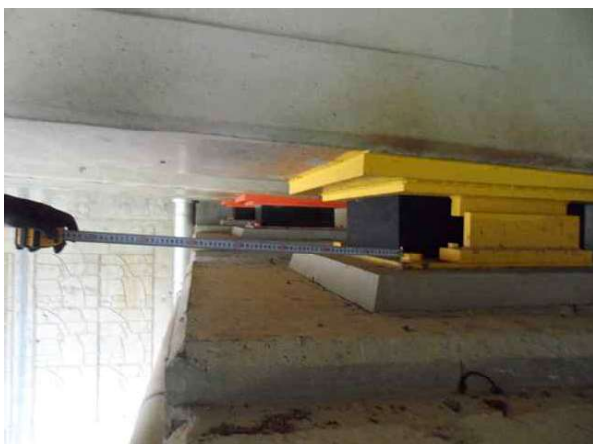
받침장치 연단거리 측정
