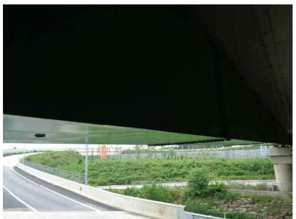
거더외부 S3 상태양호
