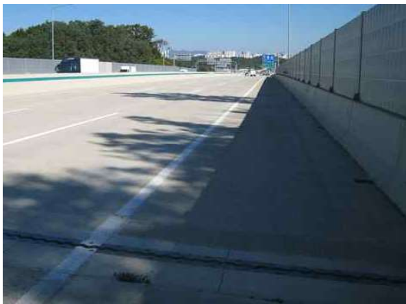
방호벽 상태양호 - 금회
