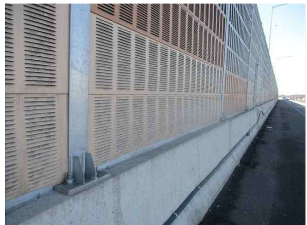
방호벽 S3 상태양호
