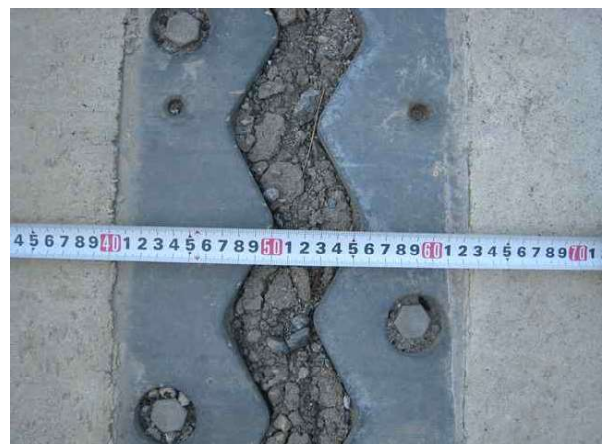
신축이음 이동량 측정
