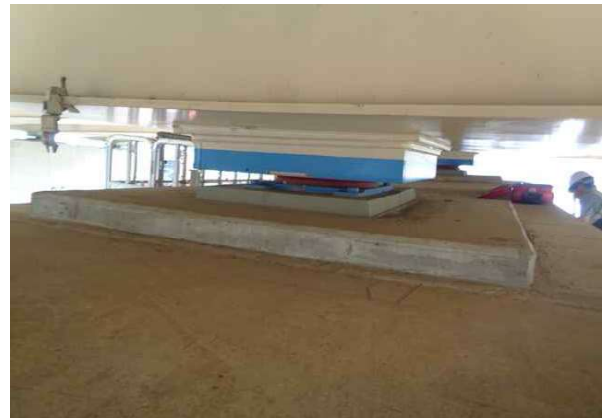
P6 교량받침 상태양호
