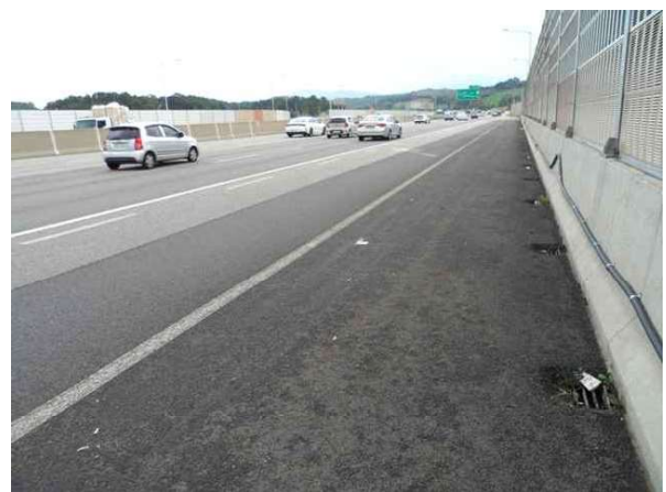
교면포장 S2 상태양호
