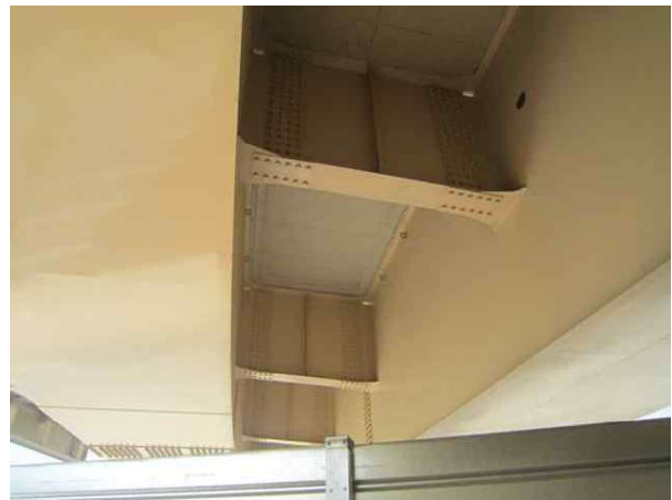
바닥판 하면 S1 상태양호
