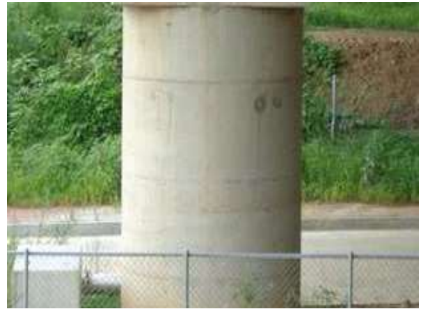
교각 P3 기둥부 상태양호
