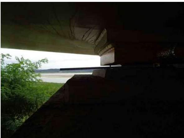
받침장치 연단거리 측정
