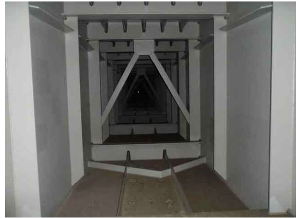
거더내부 S4 상태양호
