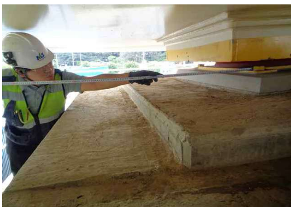
받침장치 연단거리 측정
