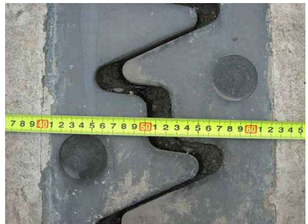
신축이음 이동량 측정
