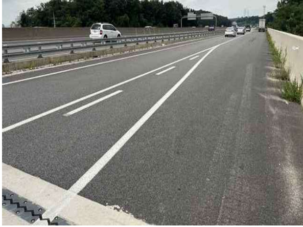
교면포장 S1 상태양호
