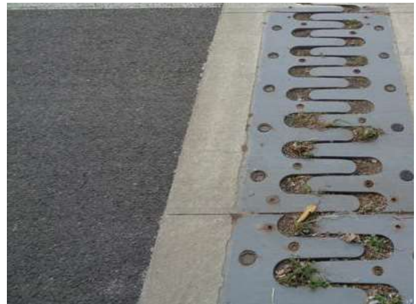
신축이음 A2 후타재 상태양호
