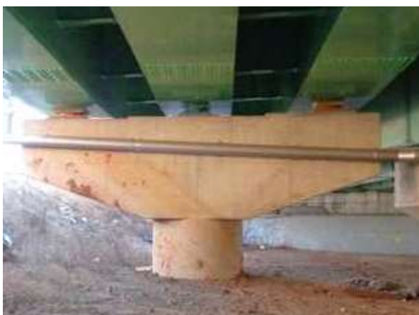
교각 P1 코핑부 상태양호
