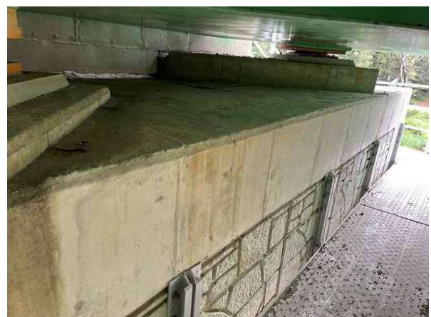
교대 A2 상태양호
