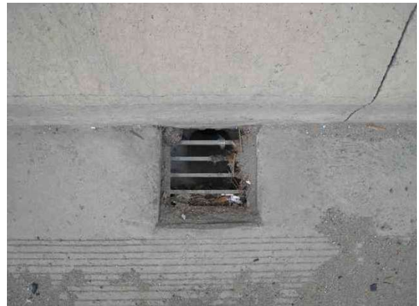
배수구 상태 양호
