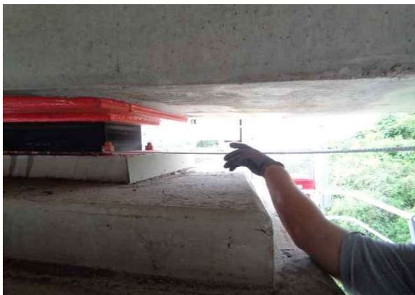
받침장치 연단거리 측정
