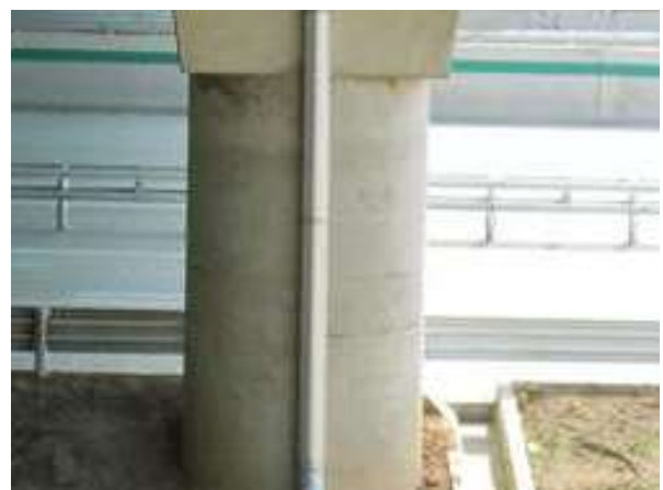
교각 P1 기둥부 상태양호
