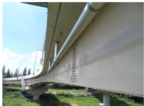
배수관 상태 양호
