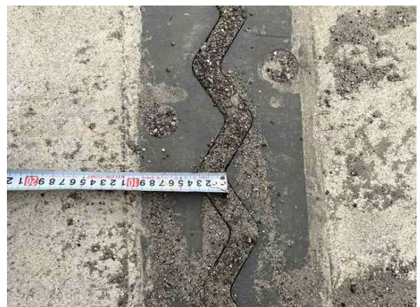
신축이음 이동량 측정
