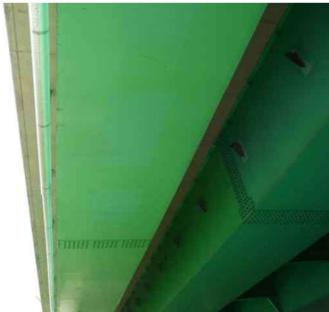
바닥판 하면 S2 상태양호
