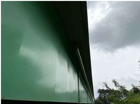
바닥판 하면 S1 상태양호
