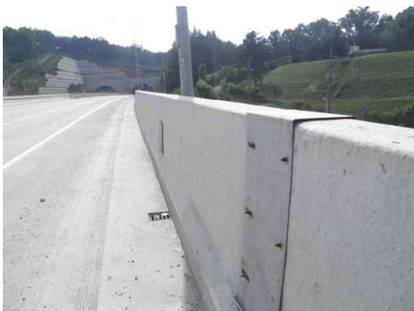
방호벽 상태 양호
