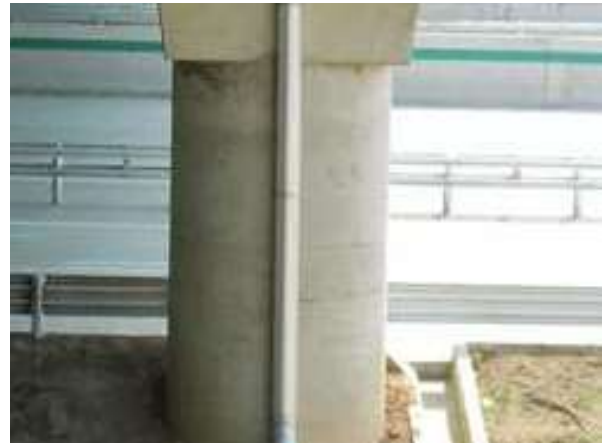
교각 P1 기둥부 상태양호
