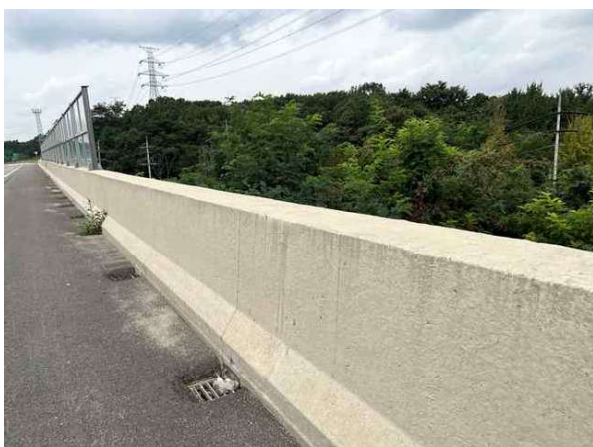
방호벽 S1 상태양호
