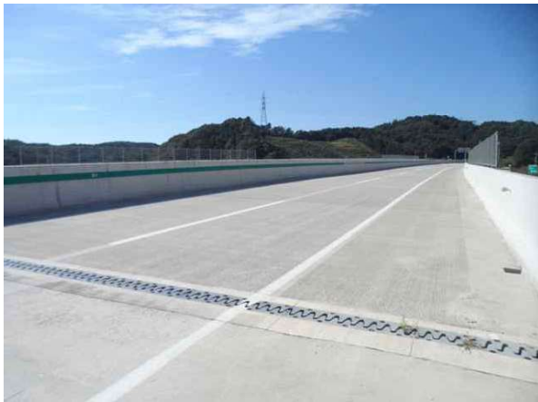
교면포장 S1 상태양호
