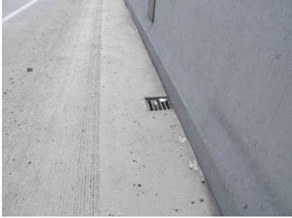
배수구 상태 양호
