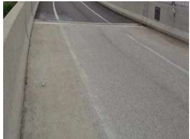
교면포장 접속도로 상태양호
