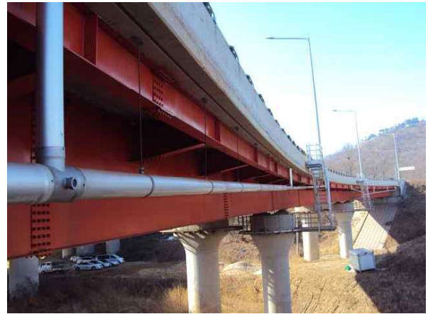
배수관 상태 양호
