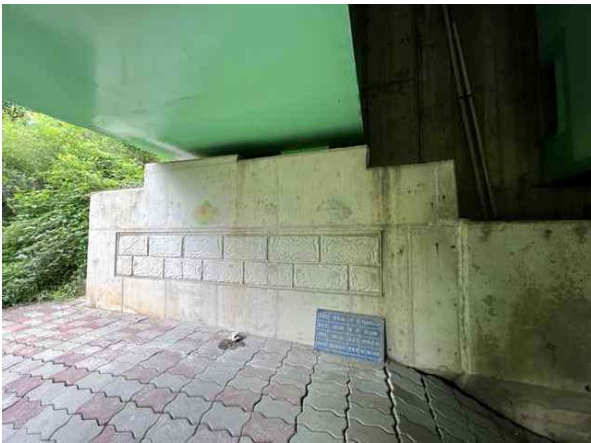
교대 A1 상태양호
