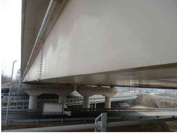
거더외부 상태양호 - 22년 상반기
