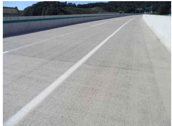
교면포장 S2 상태양호
