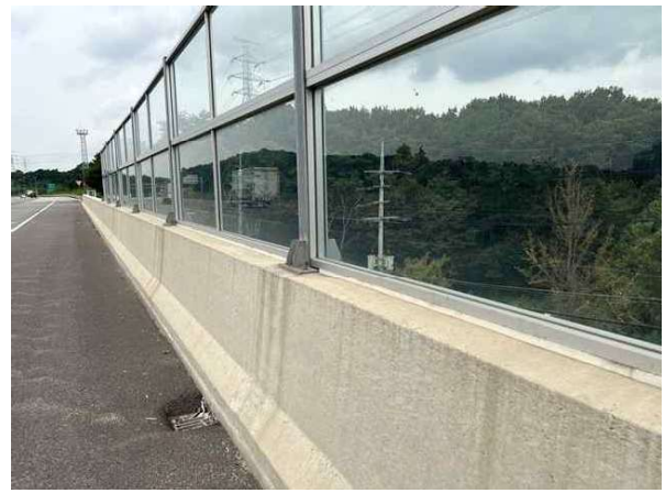
방호벽 S2 상태양호
