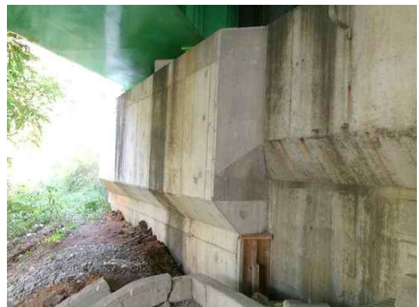
교대 A1 상태양호
