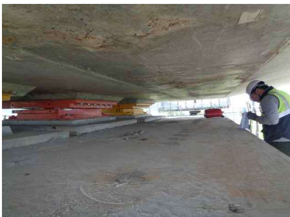
받침장치 연단거리 측정
