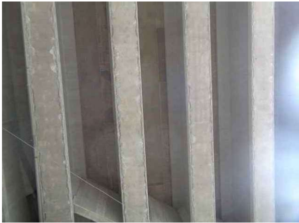
바닥판 하면 상태양호-서울방향
