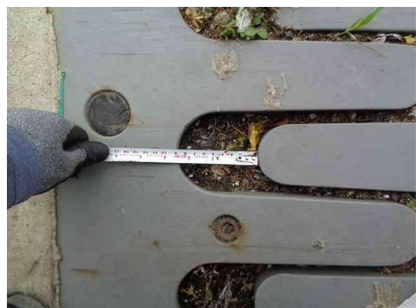
신축이음 이동량 측정
