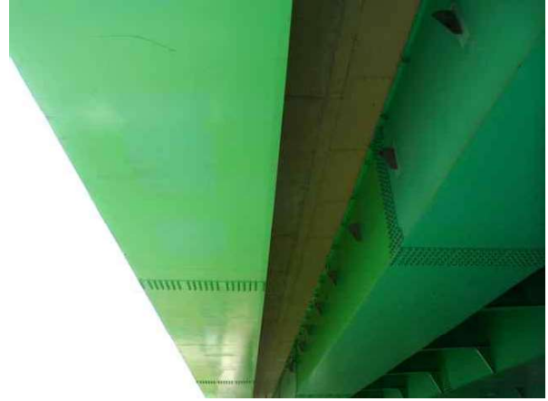
바닥판 하면 S4 상태양호
