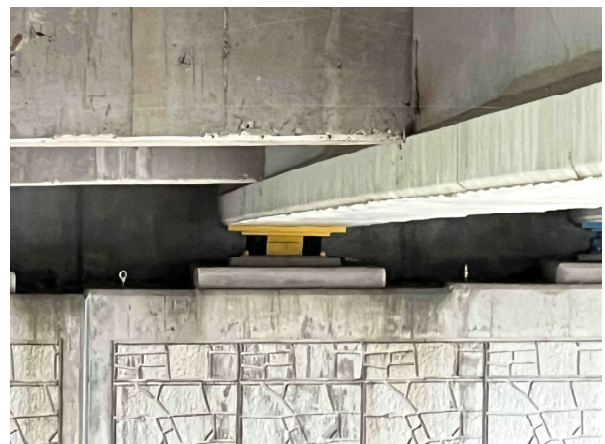
교량받침 A1-SH4 상태양호-서울방향
