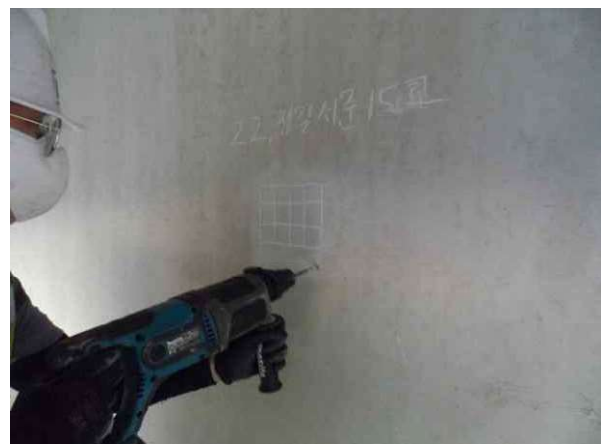
탄산화깊이 측정 현황
