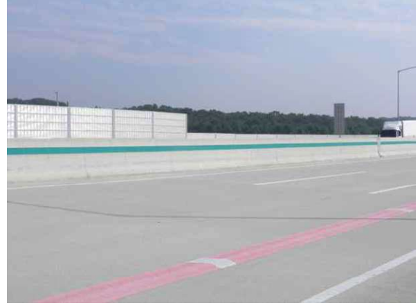
중앙분리대 상태 양호
