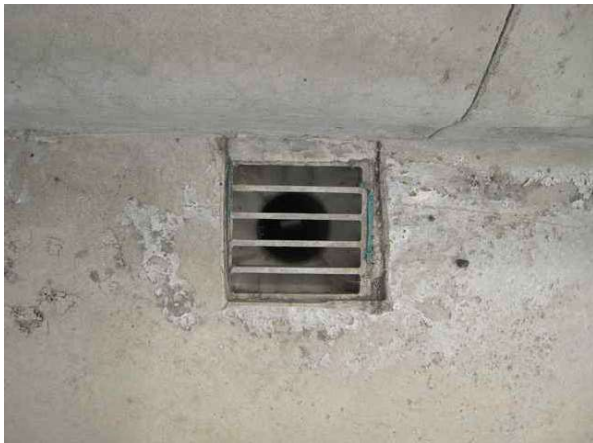
배수구 상태 양호
