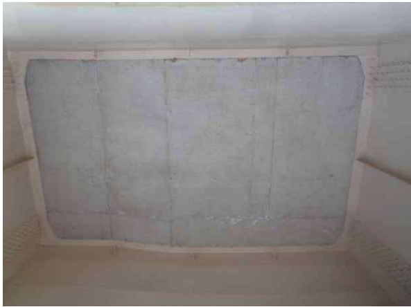
바닥판 하면 S1 상태 양호
