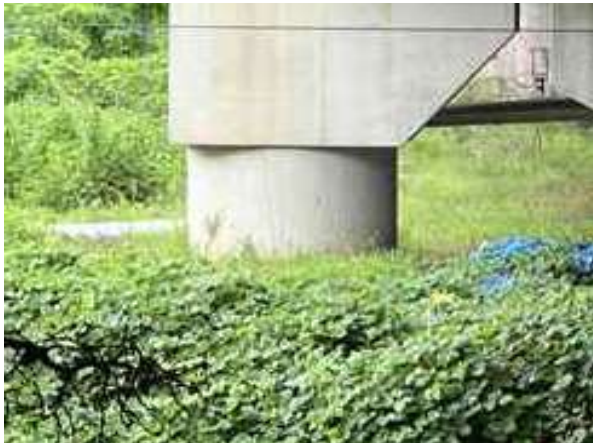
교각 P1 기둥부 상태양호
