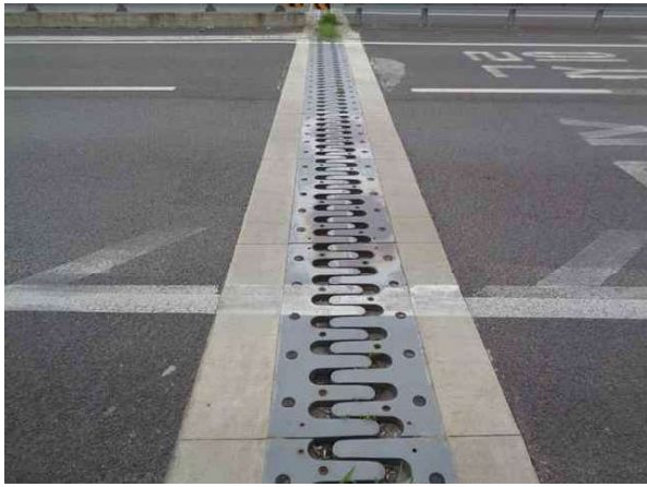
신축이음 A2 상태양호
