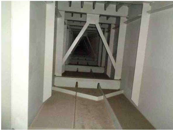
거더내부 S1 상태양호
