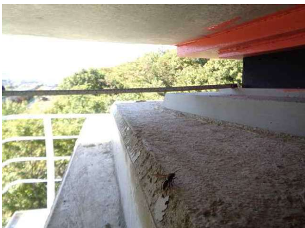
받침장치 연단거리 측정
