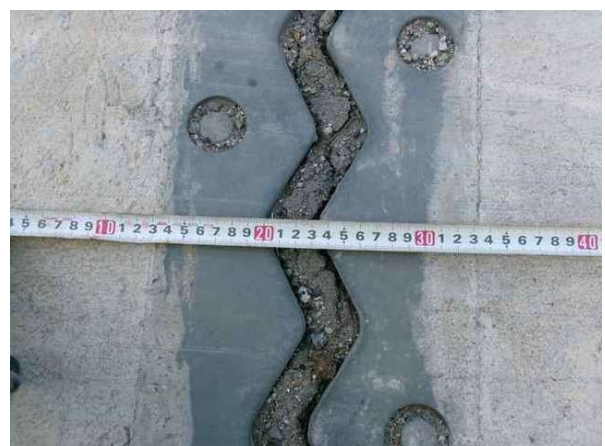
신축이음 이동량 측정
