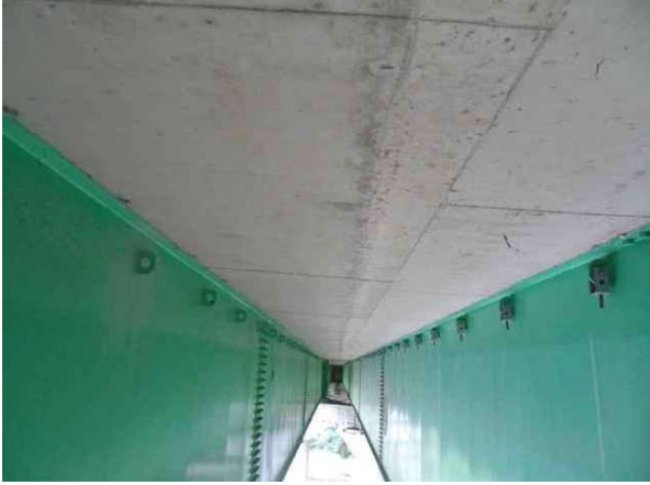
바닥판 하면 S1 상태양호
