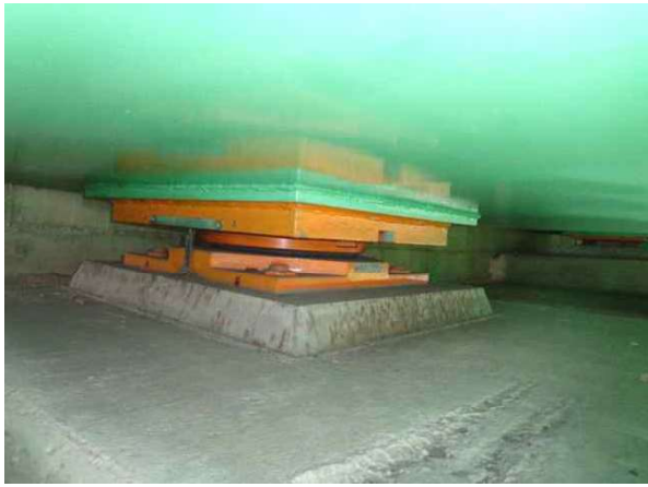
교량받침 A1-Sh2 상태양호
