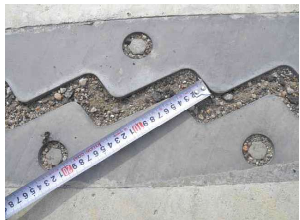
신축이음 이동량 측정
