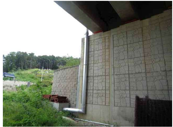
배수시설 배수관 상태양호
