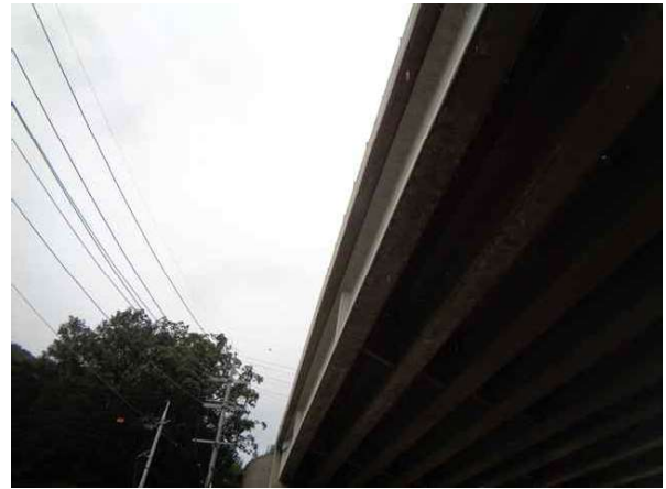
바닥판 하면 상태양호-서울방향
