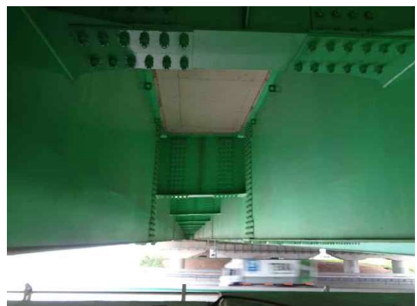
가로보 S4 상태양호
