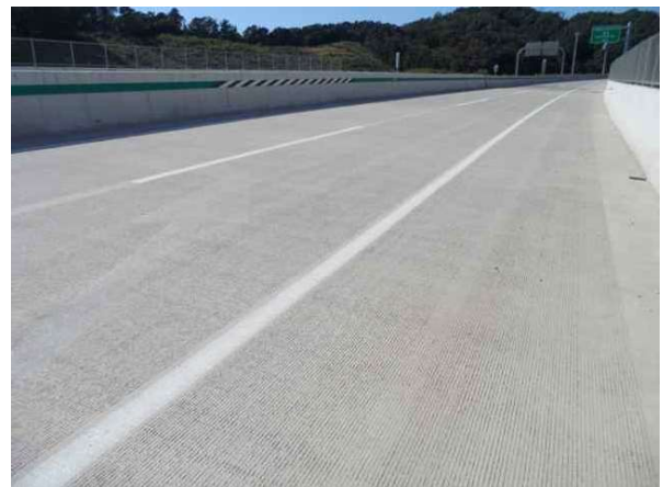
교면포장 S4 상태양호
