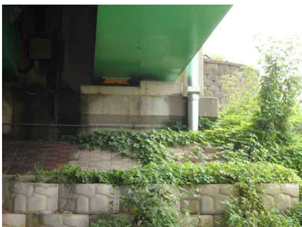
교대 A2 상태양호
