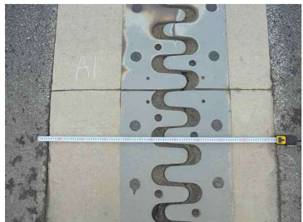
신축이음 이동량 측정
