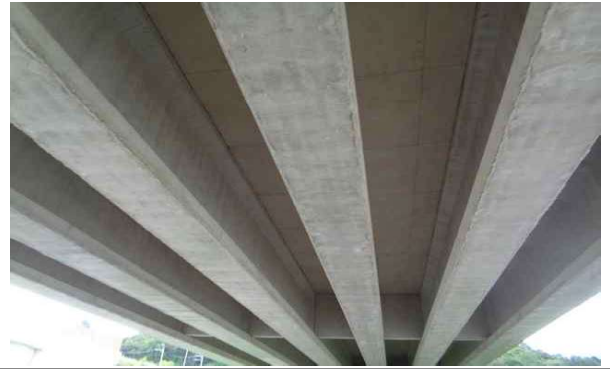
거더, 바닥판하면 전경
