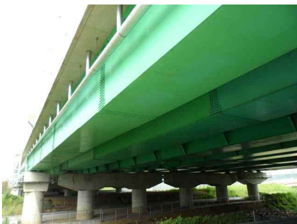
거더외부 S4 상태양호
