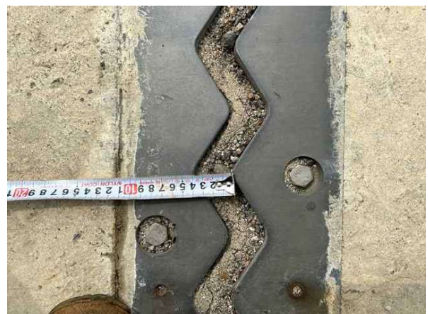
신축이음 이동량 측정
