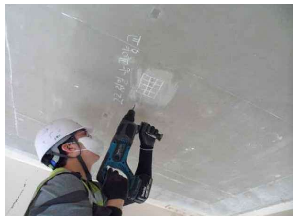
탄산화깊이 측정 현황
