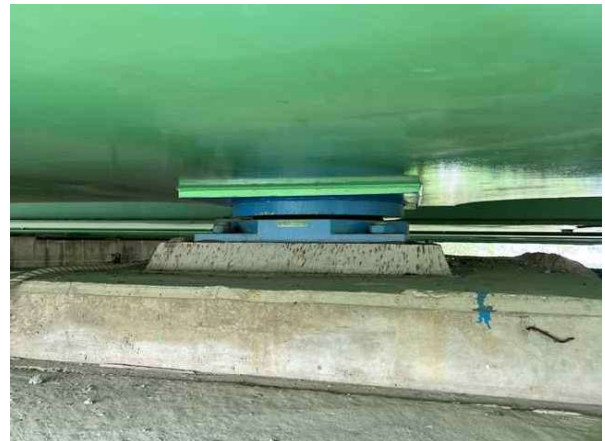
교량받침 P1-Sh1 상태양호
