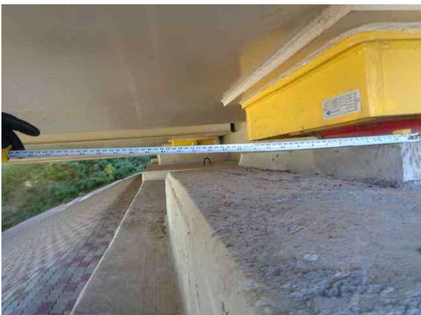
받침장치 연단거리 측정
