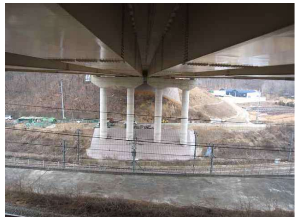
교각 상태양호 - 22년 상반기
