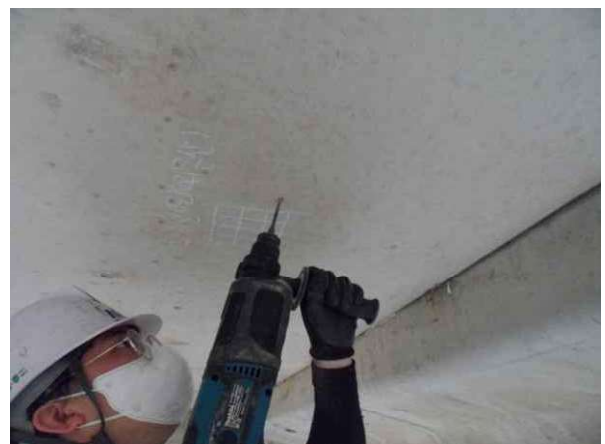
탄산화깊이 측정 현황
