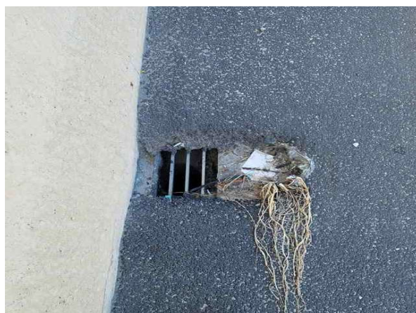
배수구 상태 양호
