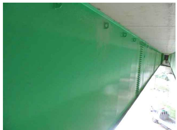
거터외부 S2 상태양호
