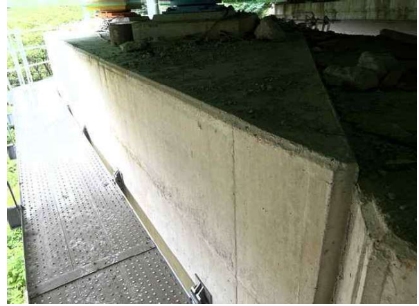
교각 P1 코핑부 상태양호
