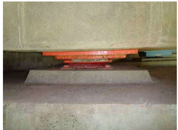
교량 받침 가동량 측정
