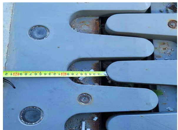
신축이음 이동량 측정
