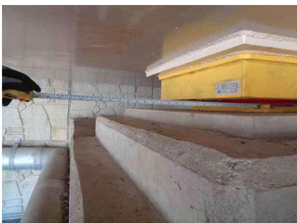
받침장치 연단거리 측정
