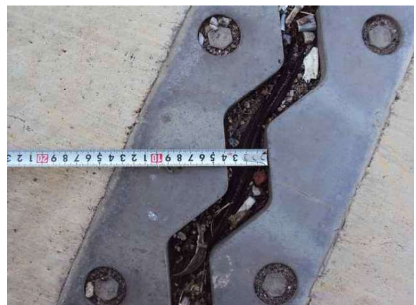
신축이음 이동량 측정
