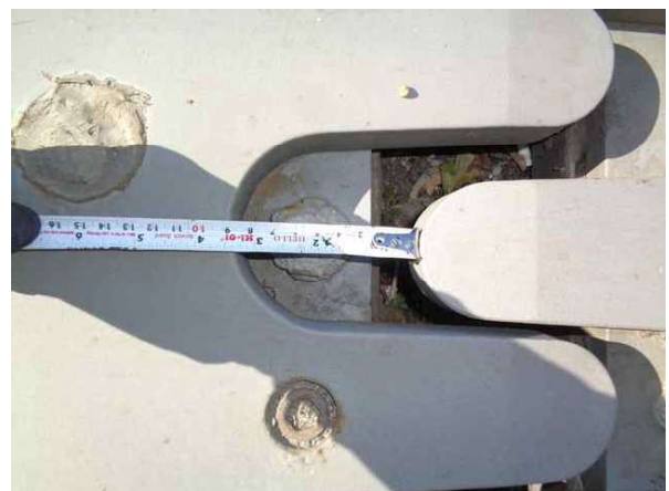
신축이음 이동량 측정
