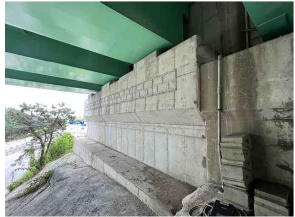
교대 A1 상태양호
