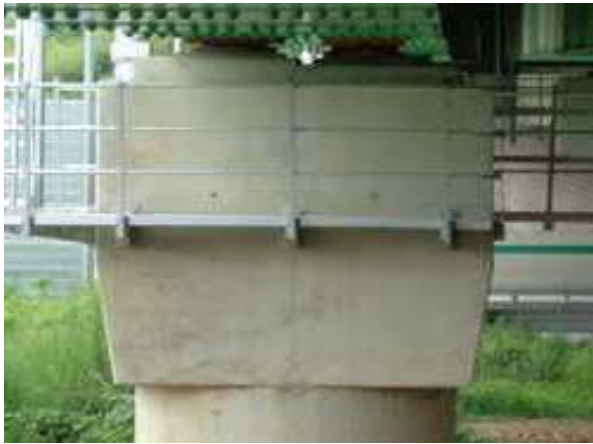
교각 P3 코핑부 상태양호
