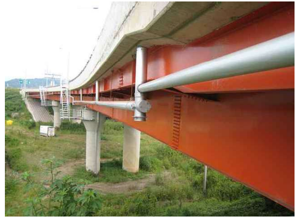
바닥판 하면 상태양호
