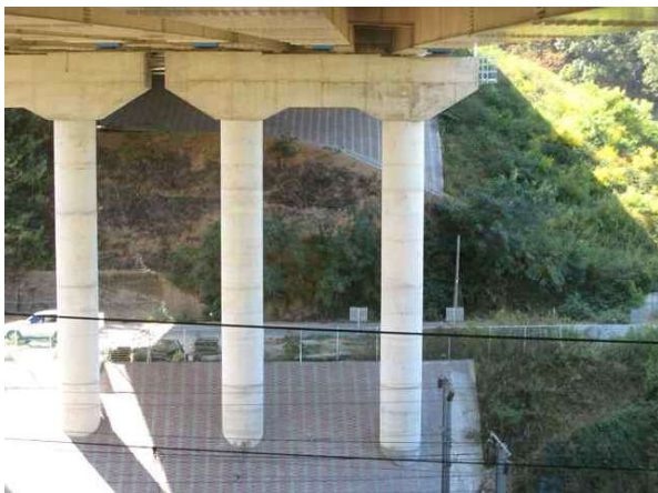
교각 상태양호 - 금회
