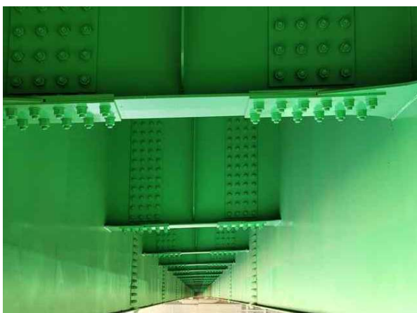
가로보 S3 상태양호
