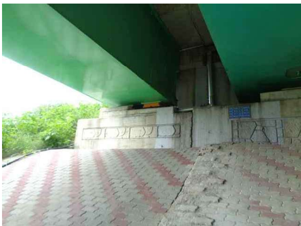
교대 A1 상태양호
