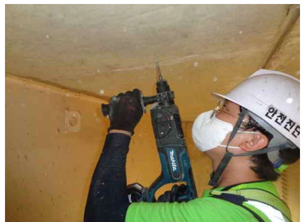
탄산화깊이 측정 현황
