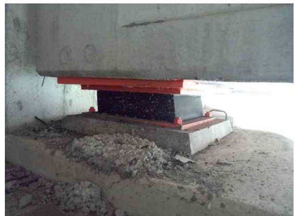
교량받침 A2-SH2 상태양호-문산방향
