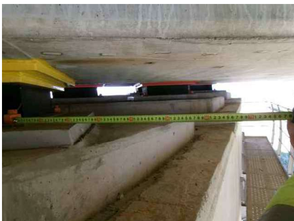
받침장치 연단거리 측정
