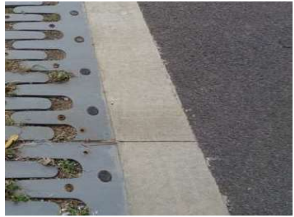
신축이음 A1 후타재 상태양호
