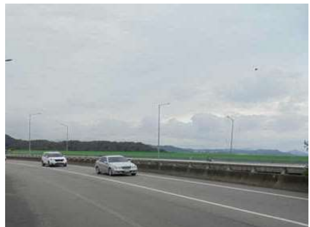
난간 및 연석 상태양호
