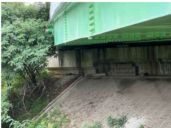
교대 A1 상태양호
