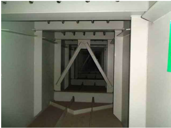
거더내부 S1 상태양호
