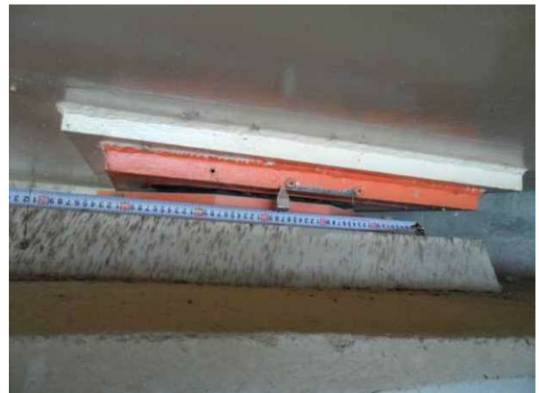
교량 받침 가동량 측정
