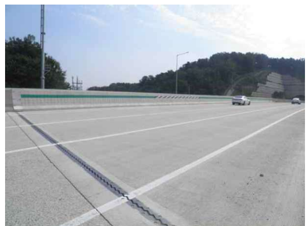
중앙분리대 상태 양호
