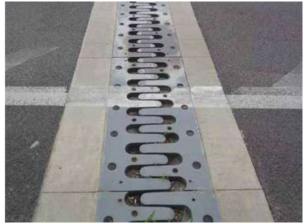
신축이음 A2 후타재 상태양호
