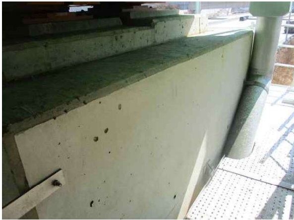
교각 P1 코핑부 상태양호
