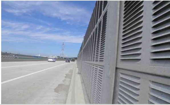
방호벽, 방음벽 전경
