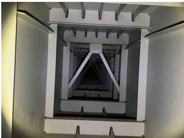
거터외부 S1 상태양호
