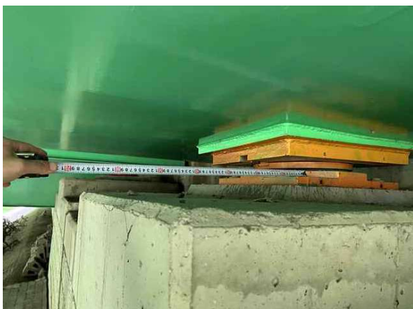
받침장치 연단거리 측정
