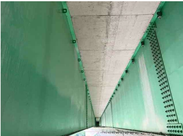
바닥판 하면 S2 상태양호
