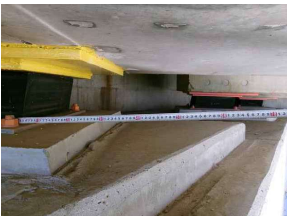
받침장치 연단거리 측정
