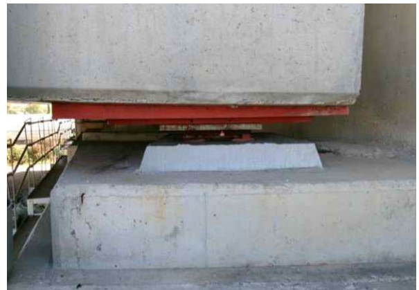
교량 받침 가동량 측정
