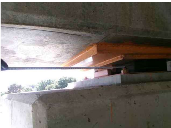
받침장치 연단거리 측정
