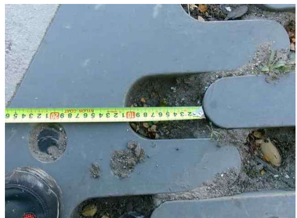
신축이음 이동량 측정
