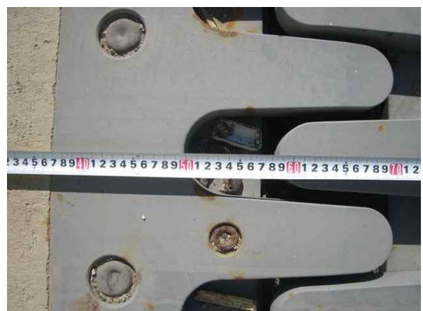
신축이음 이동량 측정
