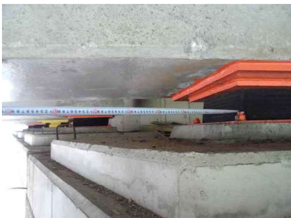
받침장치 연단거리 측정
