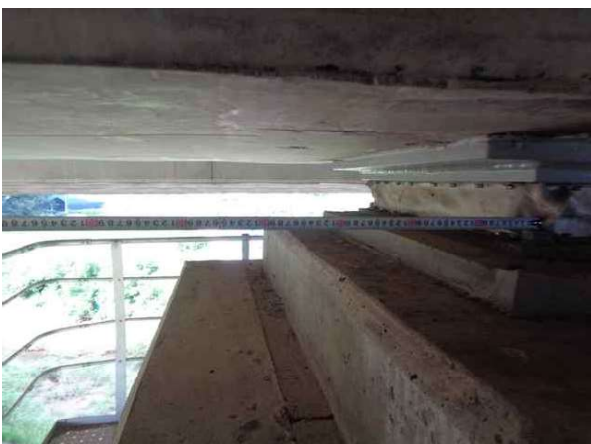
받침장치 연단거리 측정
