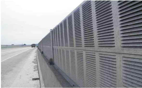
방호벽, 방음벽 전경
