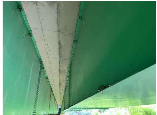
바닥판 하면 S1 상태양호
