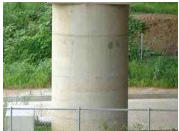
교각 P3 기둥부 상태양호
