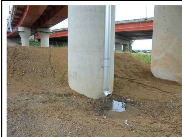
배수관 상태 양호
