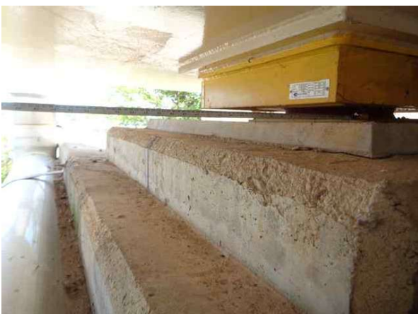
받침장치 연단거리 측정
