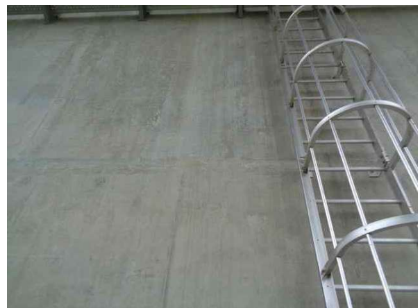
교각 P3 망상균열(1.2×2.5)
