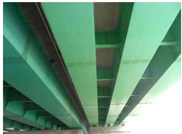
가로보 S2 상태양호
