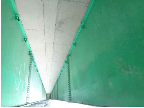
바닥판 하면 S3 상태양호
