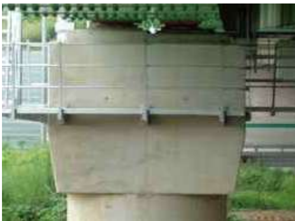
교각 P3 코핑부 상태양호
