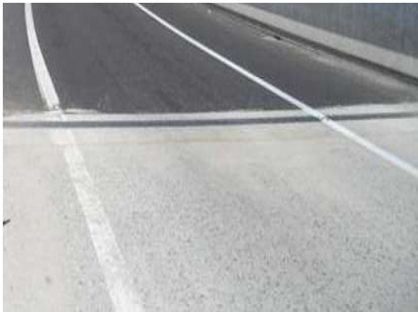
교면포장 접속도로 상태양호
