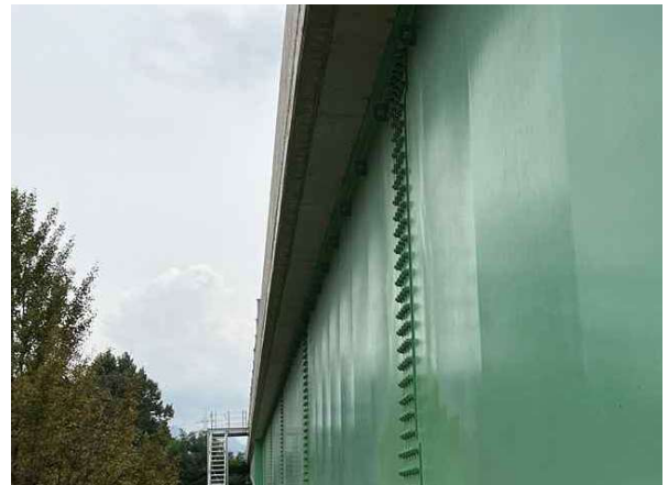
바닥판 하면 S2 상태양호
