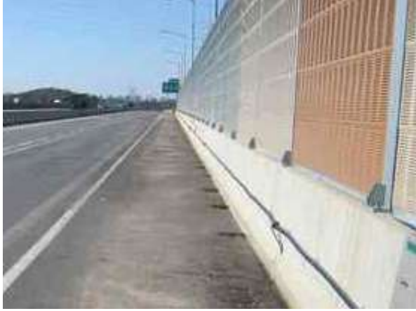
방호벽 S1 상태양호
