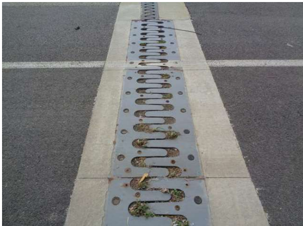
신축이음 A2 본체 상태양호
