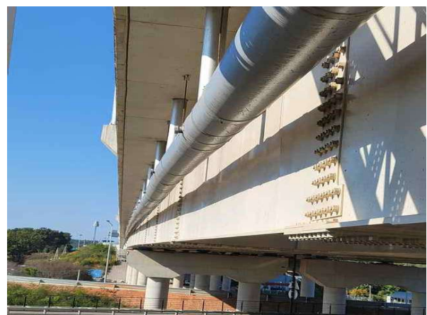
배수구 상태 양호 - 금회
