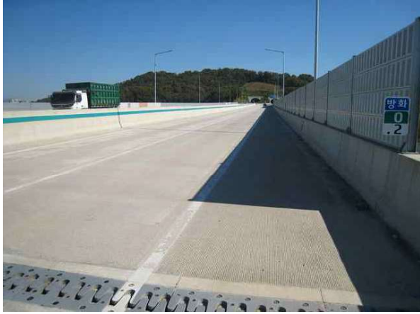
교면포장 상태양호 - 금회
