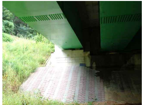
교대 A1 상태양호
