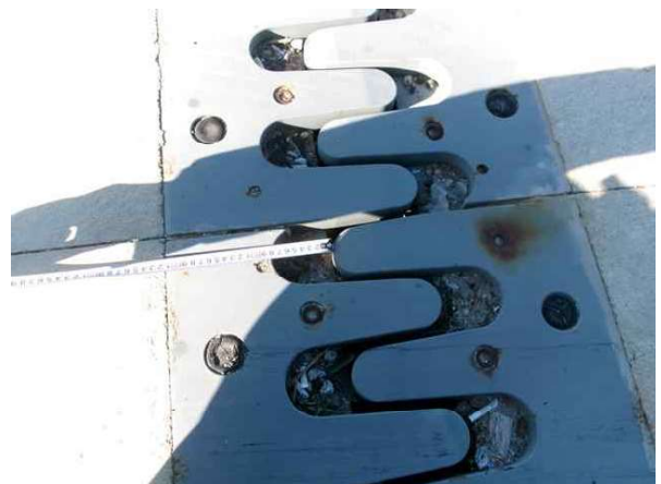
신축이음 이동량 측정
