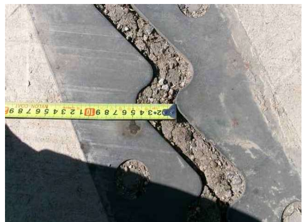
신축이음 이동량 측정
