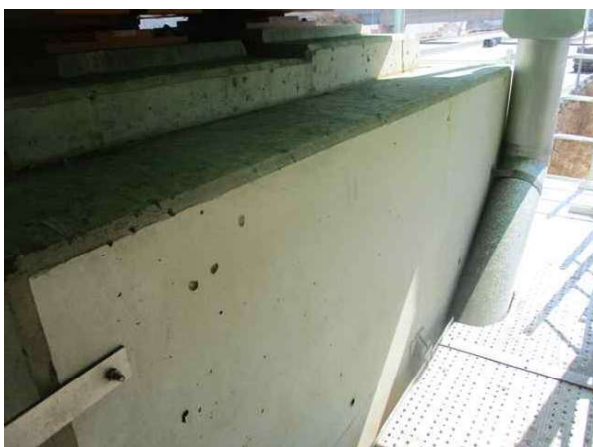
교각 P1 코핑부 상태양호
