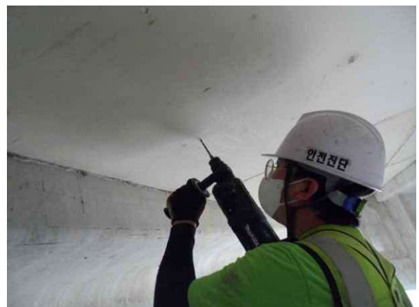
탄산화깊이 측정 현황
