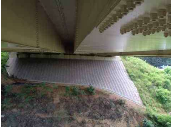
교대 상태양호 - 금회
