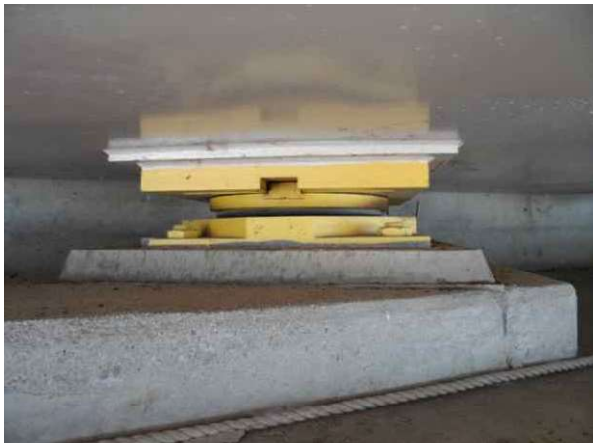
A1-Sh2 상태 양호
