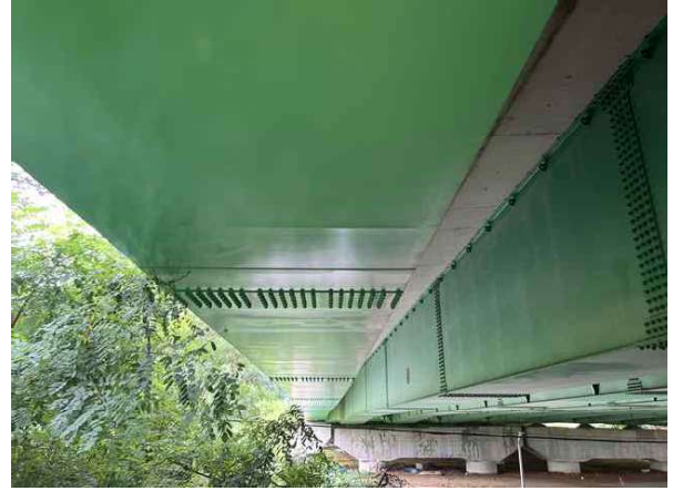
거더내부 S2 상태양호
