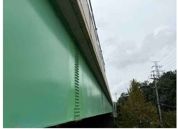
바닥판 하면 S1 상태양호
