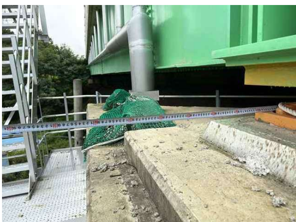
받침장치 연단거리 측정
