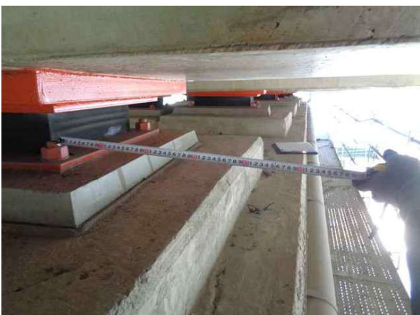
받침장치 연단거리 측정
