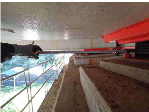
받침장치 연단거리 측정
